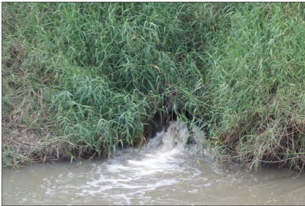
ท่อระบายน้ำเดิมต่อเชื่อมระบายสู่อ่างน้ำ
