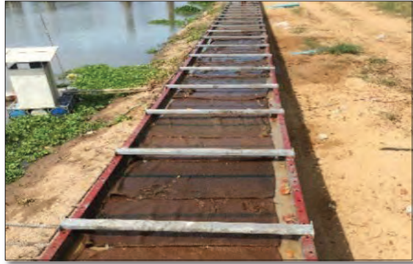
ภาพแสดงงานเทคอนกรีตและบ่มคานรัดหัวเสาเข็ม
