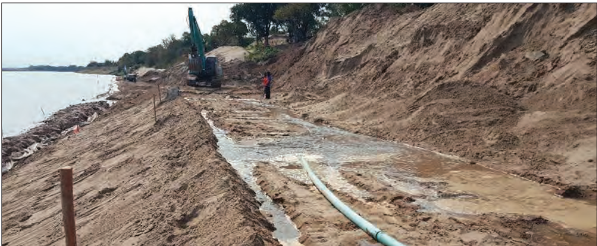
ภาพถ่ายแสดงการขังน้ำทำทรายให้แน่นหลังจากปรับ Slope ในเบื้องต้น
