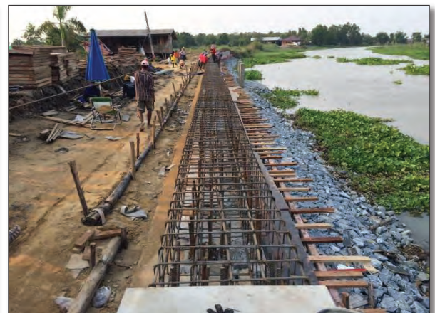
ภาพแสดงงานผูกเหล็กคันรั้วหัวเสาเข็ม
