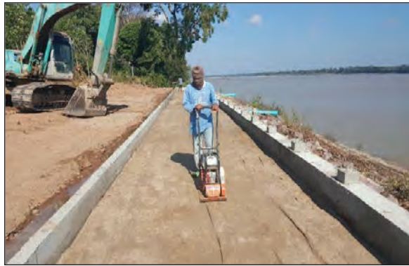
ภาพถ่ายแสดงการถมทรายปรับระดับสำหรับงานก่อสร้างทางเท้า
