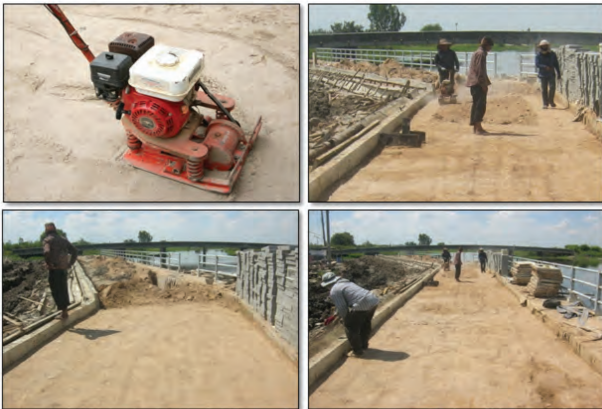
ภาพแสดงการเตรียมพื้นที่ก่อสร้างทางเท้าปูแผ่นพื้นคอนกรีตบล็อกประสาน
