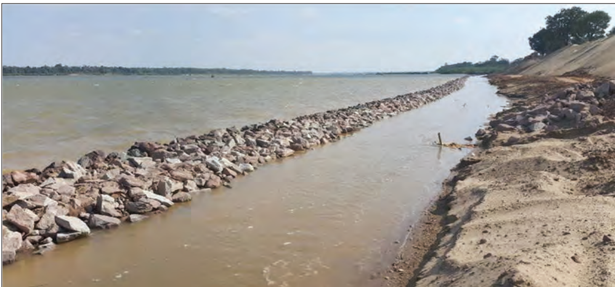
ภาพถ่ายแสดงคันหินหินเขื่อนเมื่อทำการทิ้งหิน Slope ด้านในแล้วเสร็จ
