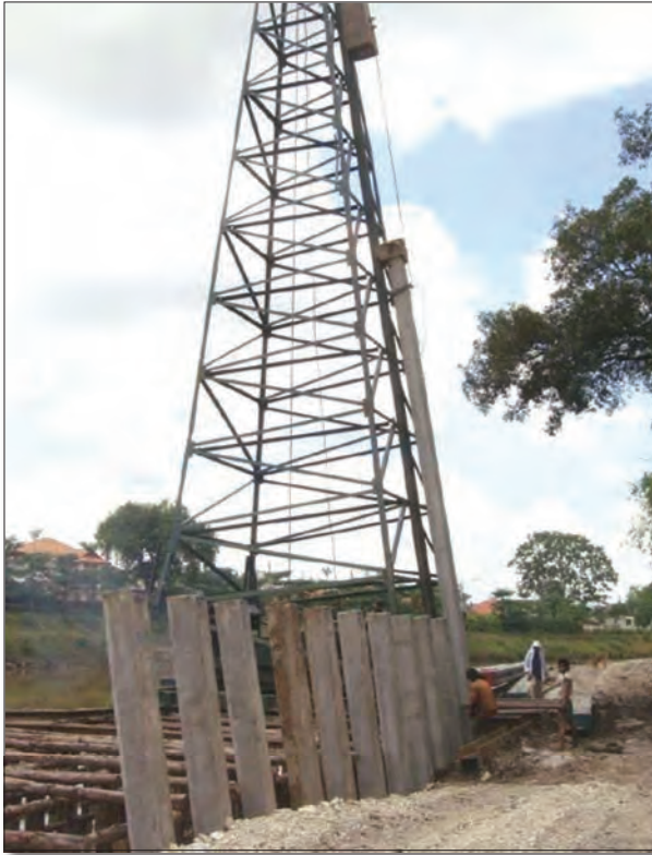
ภาพแสดงการตอกเสาเข็มคอนกรีตอัดแรง B (ตอกเอียง)
