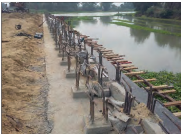
ภาพแสดงงานผูกเหล็กคันรั้วหัวเสาเข็ม
