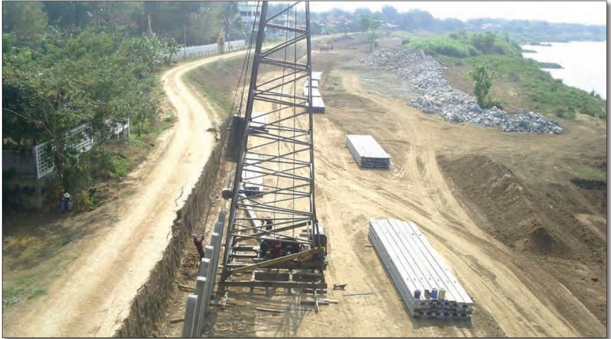
ภาพแสดงการปรับดินริมตลิ่งเพื่อทำพื้นที่สำหรับตอกเสาเข็ม
