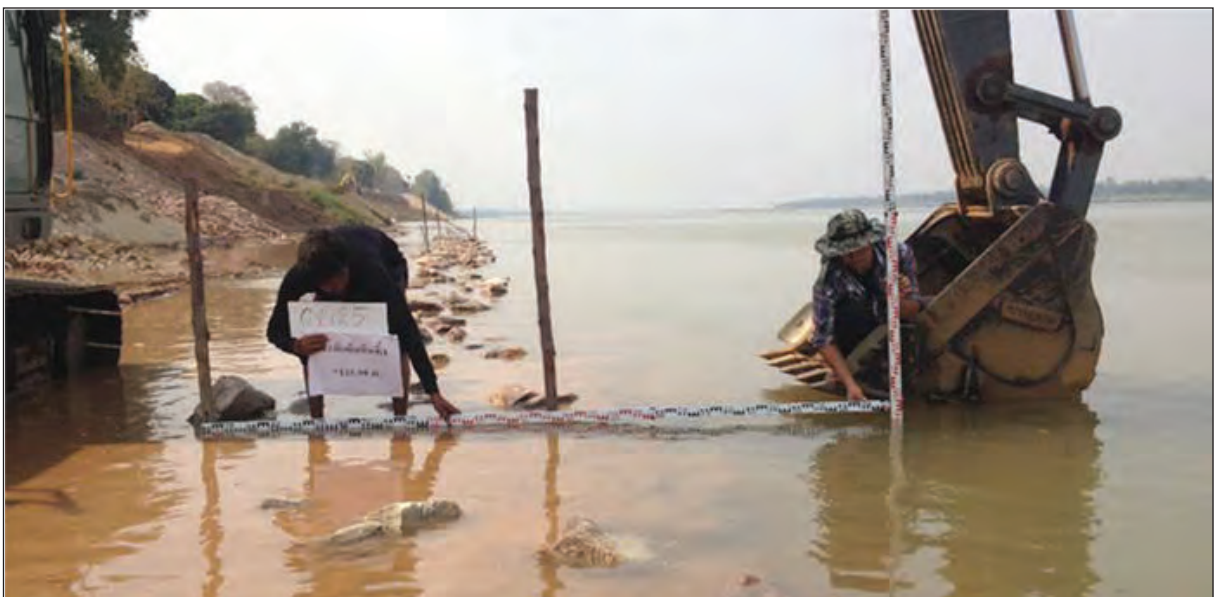
ภาพแสดงการตรวจสอบคันหินด้านนอก
