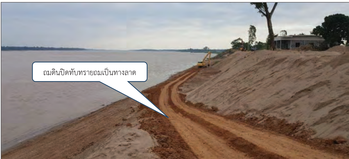
ภาพถ่ายแสดงการถมดินปิดทับเพื่อเป็นทางลาด
