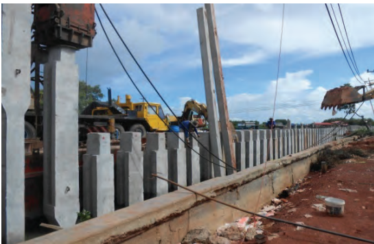
ภาพแสดงการส่งงานตอกเสาเข็มคอนกรีตอัดแรง
