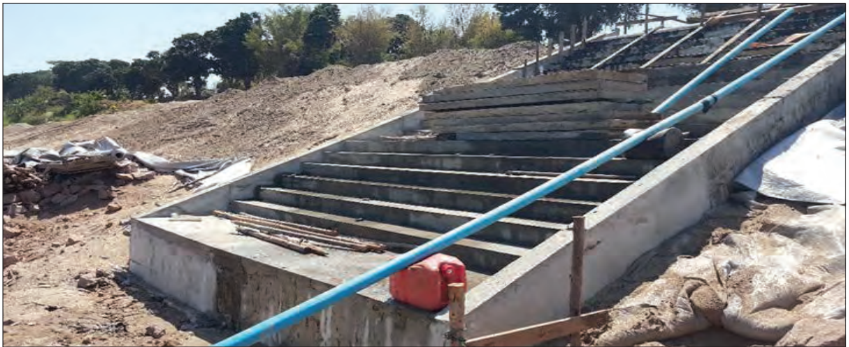
ภาพถ่ายแสดงงานก่อสร้างบันได
