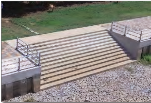
ภาพแสดงงานก่อสร้างบันไดคอนกรีตเสริมเหล็กแบบทางลงขวางเชื่อมป้องกันตลิ่ง
