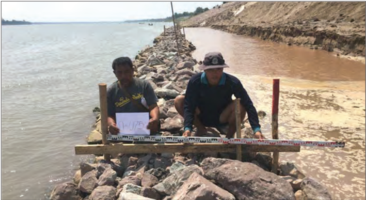
ภาพแสดงการตรวจสอบความกว้างของสันคันหินดินเขื่อน
