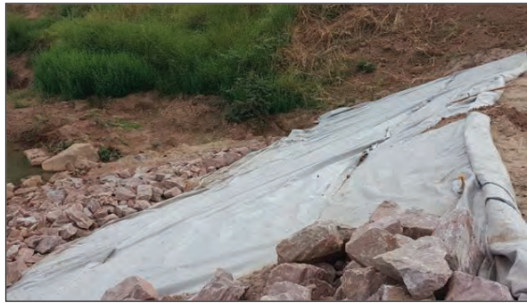
ภาพแสดงปูแผ่นใยสังเคราะห์ปิดทับทรายแล้วทิ้งหินใหญ่ปิดทับ
