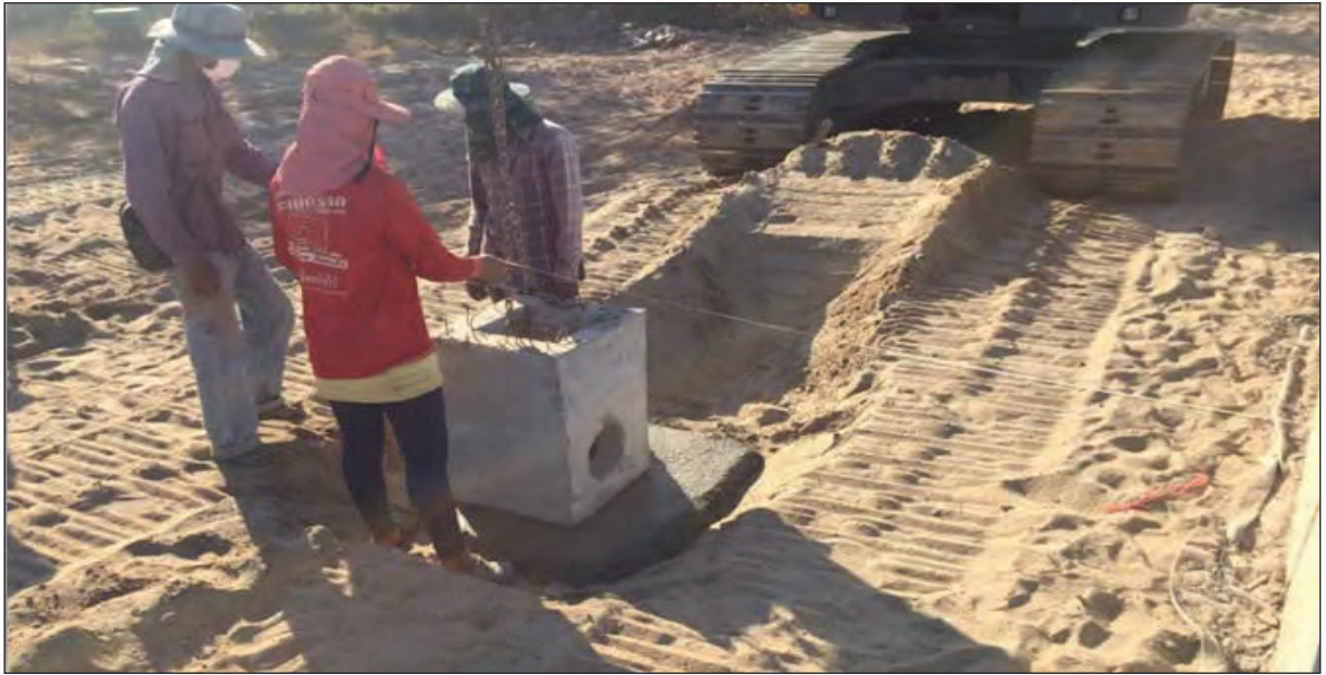
ภาพแสดงการติดตั้งบ่อพักคอนกรีตเสริมเหล็ก
