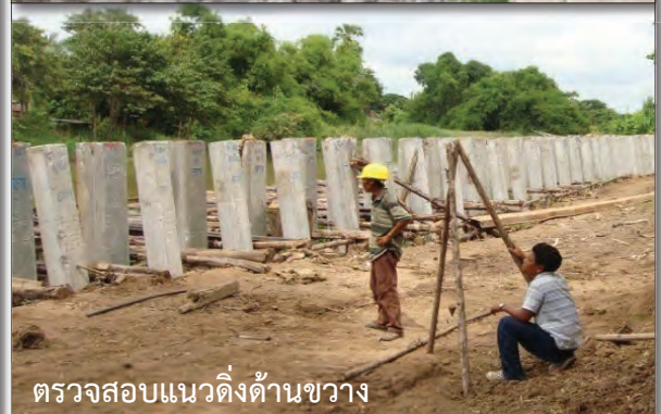
ภาพแสดงการตอกเสาเข็มคอนกรีตอัดแรง A (ตอกตรง)
