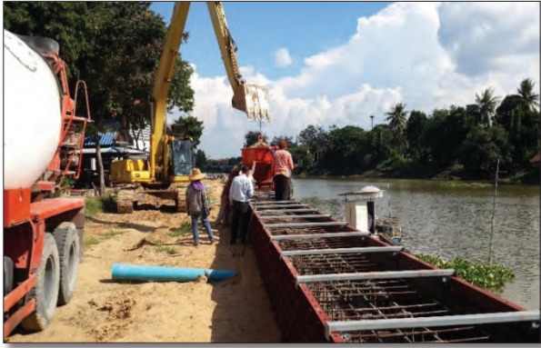
ภาพแสดงงานเทคอนกรีตและบ่มคานรัดหัวเสาเข็ม
