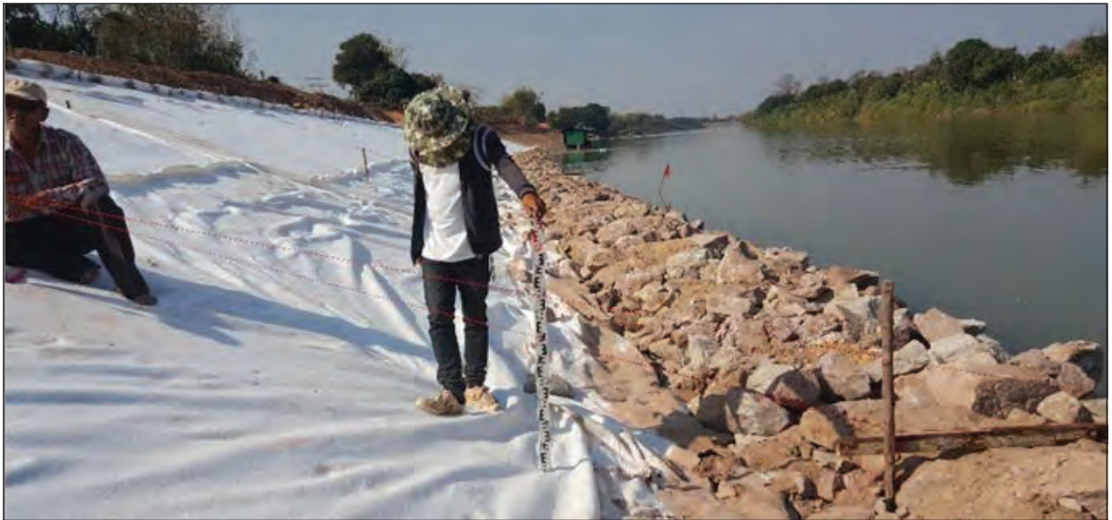
ภาพถ่ายแสดงการตรวจวัดความหนาของชั้นหินเรียงชั้นแรกปิดทับคันหินดินเขื่อน
