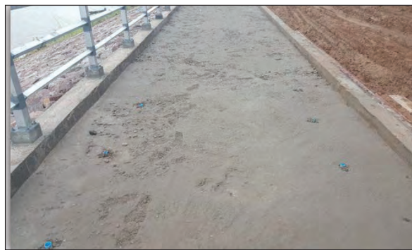
ภาพถ่ายแสดงการเทคอนกรีตหยาบแล้วเสร็จแสดงการฝังท่อ PVC. ขนาด 1"
