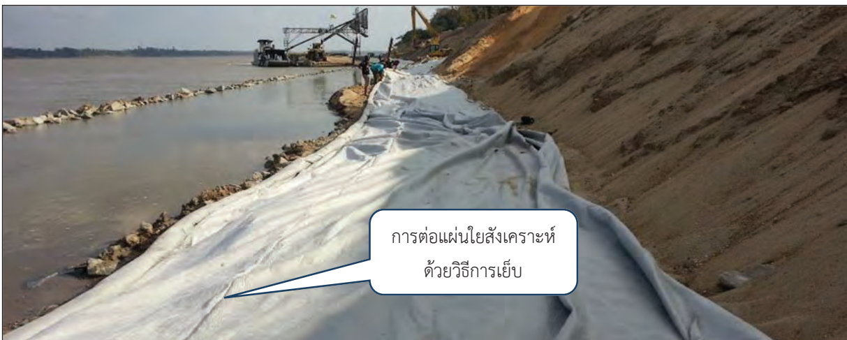
ภาพถ่ายแสดงการปูวัสดุกรอง (แผ่นโพลีเอทิลีน) ความกว้าง ๔ เมตร เย็บต่อกัน ๒ ผืน
