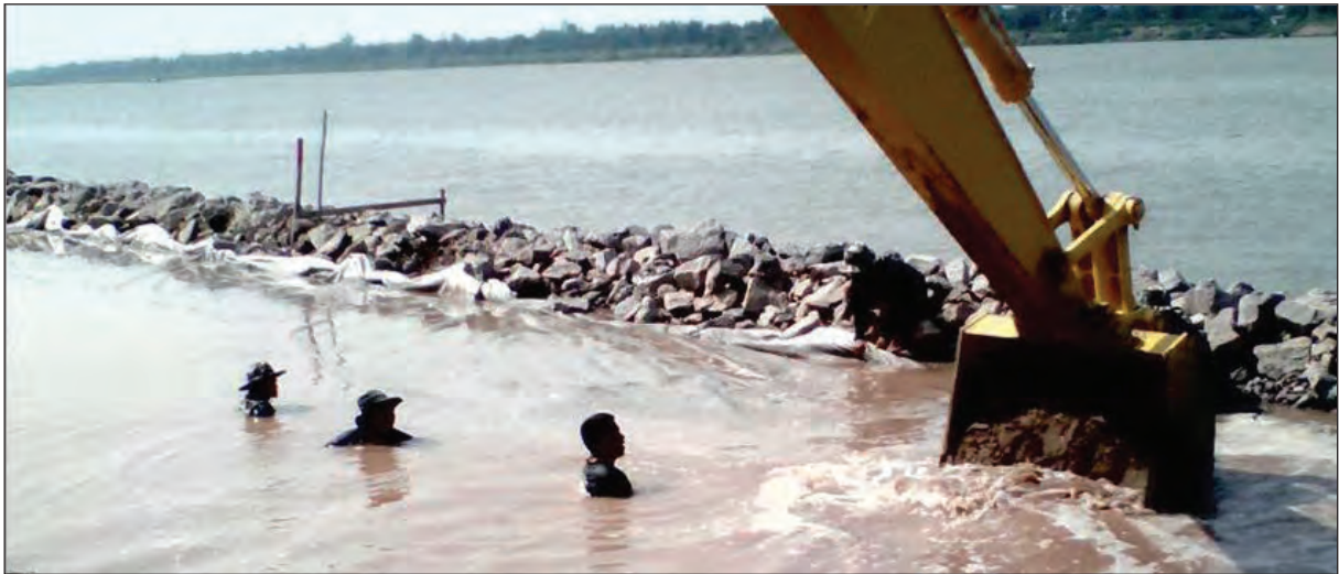
ภาพถ่ายแสดงการปูวัสดุกรอง ความกว้าง ๓ เมตร เย็บต่อกัน ๒ ผืน (แผ่นใยสังเคราะห์) ขณะทำการถมทรายต้องใช้คนช่วยกดทับแผ่นใยสังเคราะห์ด้านล่างและช่วยยึดรั้งด้านบน
