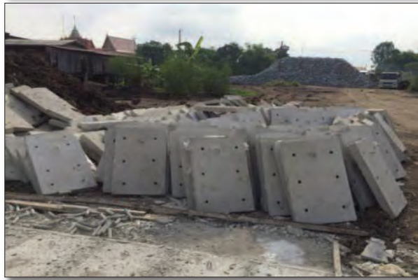
ภาพแสดงการผูกเหล็ก เทคอนกรีต กองแผงกรู คสล.
