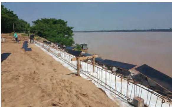
ภาพถ่ายแสดงการเสริมเหล็กคานรับราวกันตก จะเห็นเสาเข็มฝังอยู่ในคาน ๒๐ เซนติเมตร
