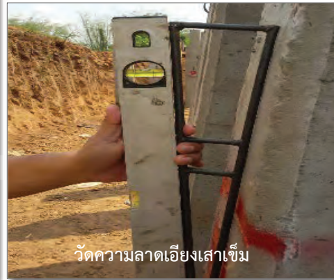
ภาพแสดงการตอกเสาเข็มคอนกรีตอัดแรง B (ตอกเอียง)
