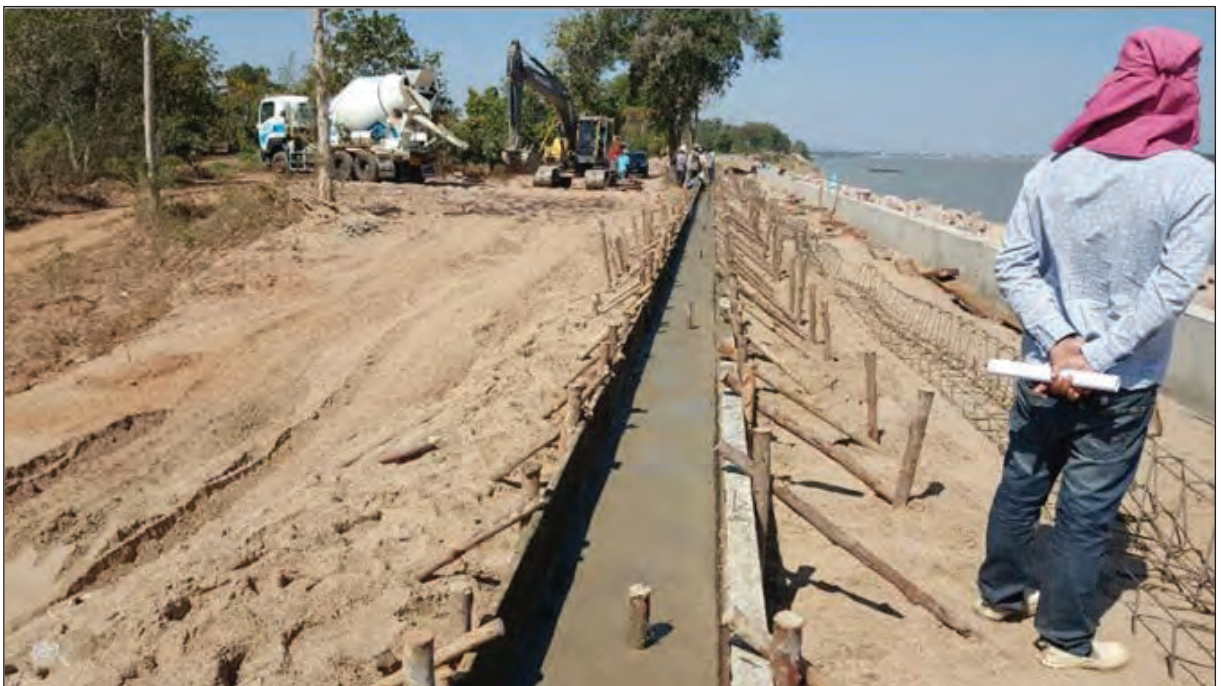
ภาพถ่ายแสดงงานเทคอนกรีตหยาบ
