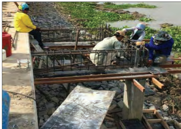
ภาพแสดงงานก่อสร้างบันไดคอนกรีตเสริมเหล็กแบบทางลงขวางเชื่อมป้องกันตลิ่ง
