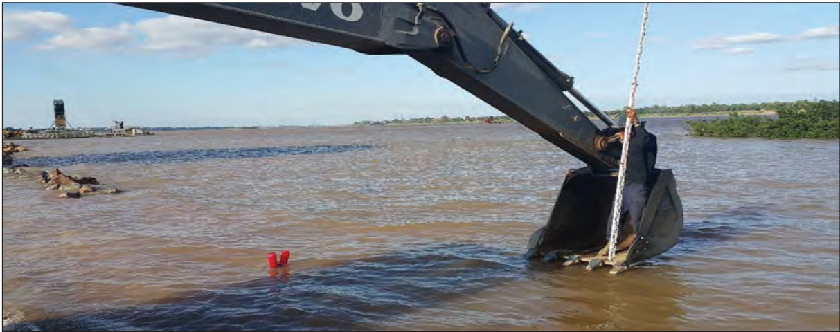
ภาพแสดงตำแหน่งการติดตั้งทุ่นลอยเพื่อแสดงตำแหน่งปลาย Slope คันหินทิ้งด้านใน
