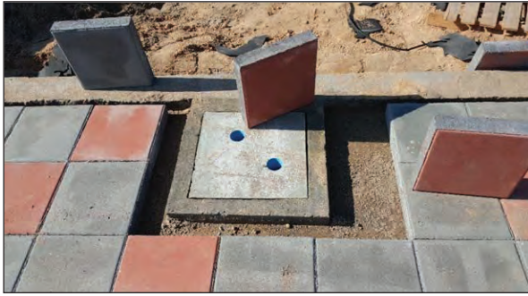
ภาพถ่ายแสดงงานปูบล็อกในตำแหน่งที่เป็นบ่อพักเป็นเศษให้ตัดบล็อกใส่ให้พอดี
