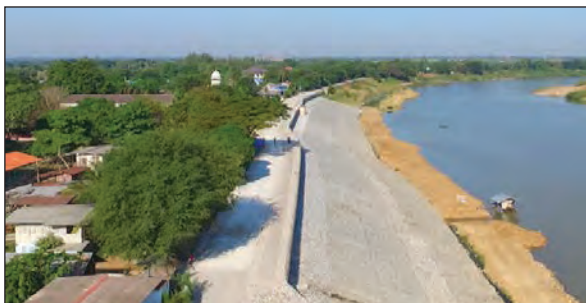
ตัวอย่างเขื่อนป้องกันตลิ่งแบบเสาเข็มที่ก่อสร้างแล้วเสร็จ
