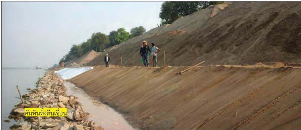
ภาพถ่ายแสดงการถมทรายในช่วงตอน (Step) ที่ 1
