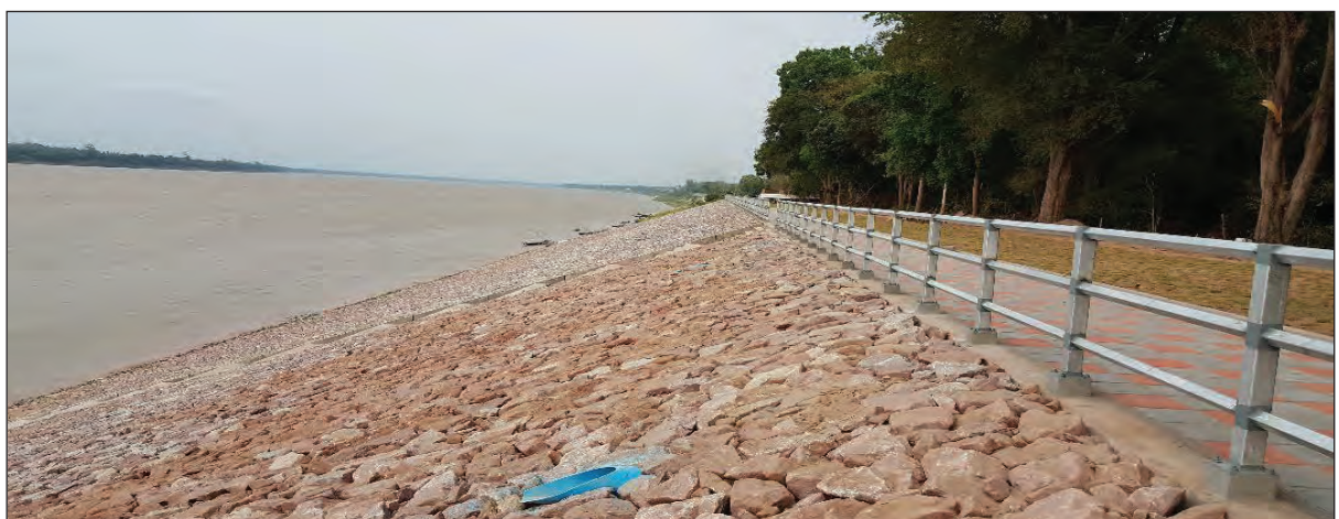
ตัวอย่างเขื่อนป้องกันตลิ่งแบบทิ้งหิน/เรียงหิน ที่ก่อสร้างแล้วเสร็จ
