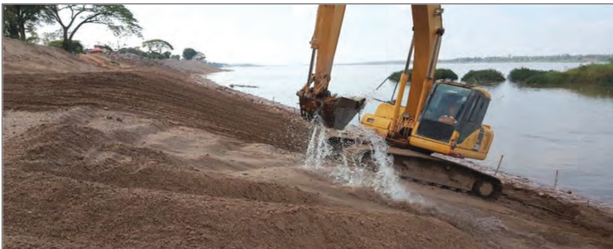
ภาพถ่ายแสดงการปรับระดับและทำทรายถมให้แน่น
