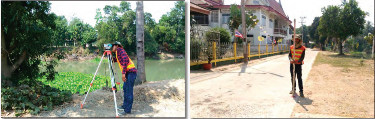
งานสำรวจหมุดทาง
