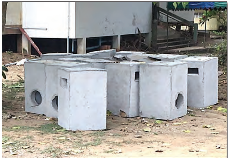
ภาพแสดง บ่อพัก คสล.หล่อสำเร็จแล้วยกไปติดตั้ง
