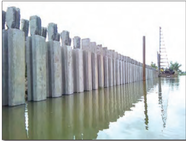
ภาพแสดงการตอกเสาเข็มคอนกรีตอัดแรง A (ตอกตรง) ด้วยปั้นจั่นโป๊ะ
