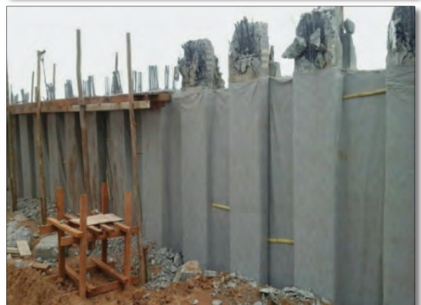
ภาพแสดงการติดตั้งแผ่นใยสังเคราะห์หลังแผงกรู คสล.
