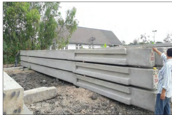
ภาพแสดงการตรวจสอบขนาดเสาเข็มก่อนนำไปตอก
