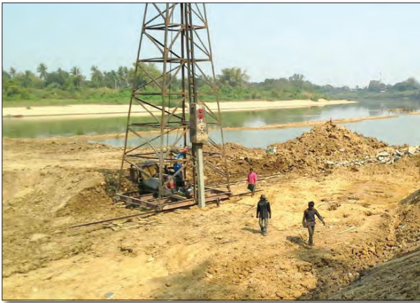
ภาพแสดงการตอกเสาเข็มด้วยปั้นจั่นโครงเหล็ก
