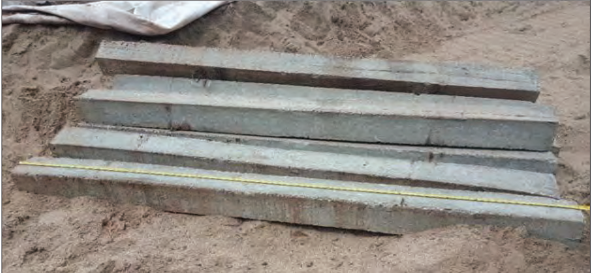
ภาพถ่ายแสดงเสาเข็ม คสล. ขนาด \square ๐.๑๕ เซนติเมตร ยาว ๒.๕๐ เมตร
