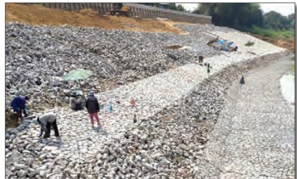
ภาพแสดงการเรียงหินใหญ่พร้อมแทรกโพรงด้วยหินเล็กหน้าเขื่อน
