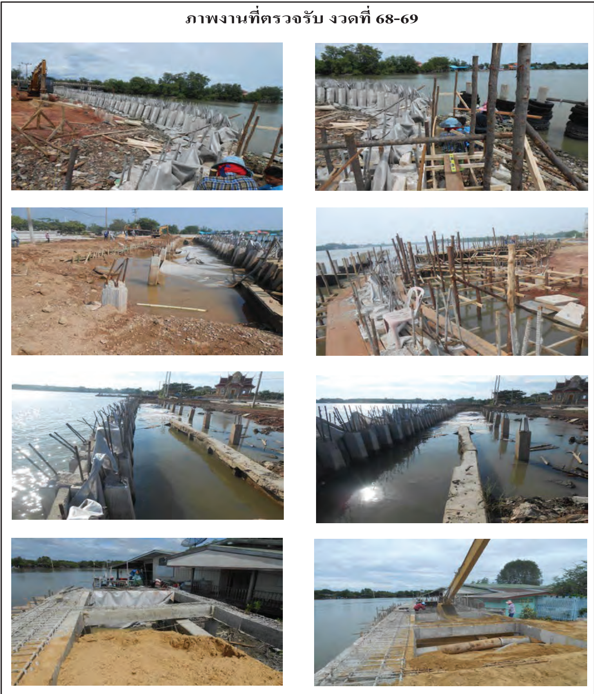
ภาพแสดงการส่งงานชั้นวัสดุกรอง และการถมทรายหลังเขื่อน
