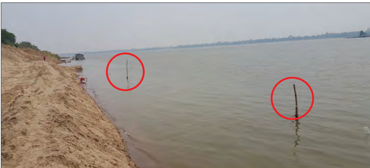
ภาพแสดงการปักแนวปลาย Slope ของคันหินดินเขื่อนด้านในและถมทรายเป็นฐานในการทำงานของเครื่องจักร
