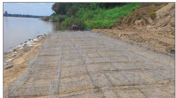
ภาพแสดงการผูกมัดขึ้นรูปแล้วนำไปวางเตรียมบรรจุหินลงกล่อง
