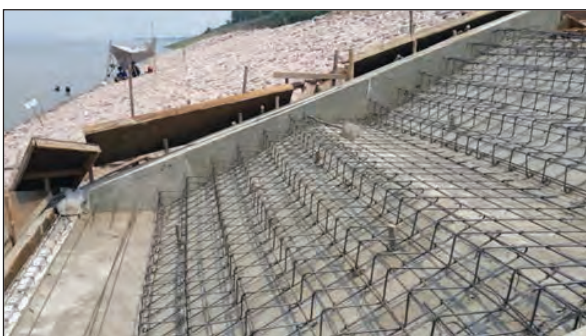
ภาพถ่ายแสดงเหล็กเสริมบันได จัดเหล็กเสริมให้อยู่ในตำแหน่ง หนุนลูกป้อนยึดแบบ
