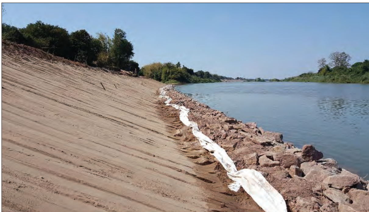
ภาพแสดงแผ่นใยสังเคราะห์ที่ปูปิดทับคันทินดินเขื่อนส่วนที่เหลือไว้สำหรับต่อทาบกับแผ่นต่อไป
