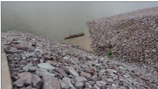
ภาพแสดงการตรวจสอบ Slope ของหินทิ้งปิดหัว - ท้ายเขื่อน ๑ : ๒
