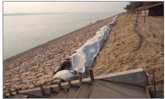
ภาพถ่ายแสดงการพับแผ่นใยสังเคราะห์เพื่อความสะดวกในการปรับระดับทรายถมในชั้นต่อไป
