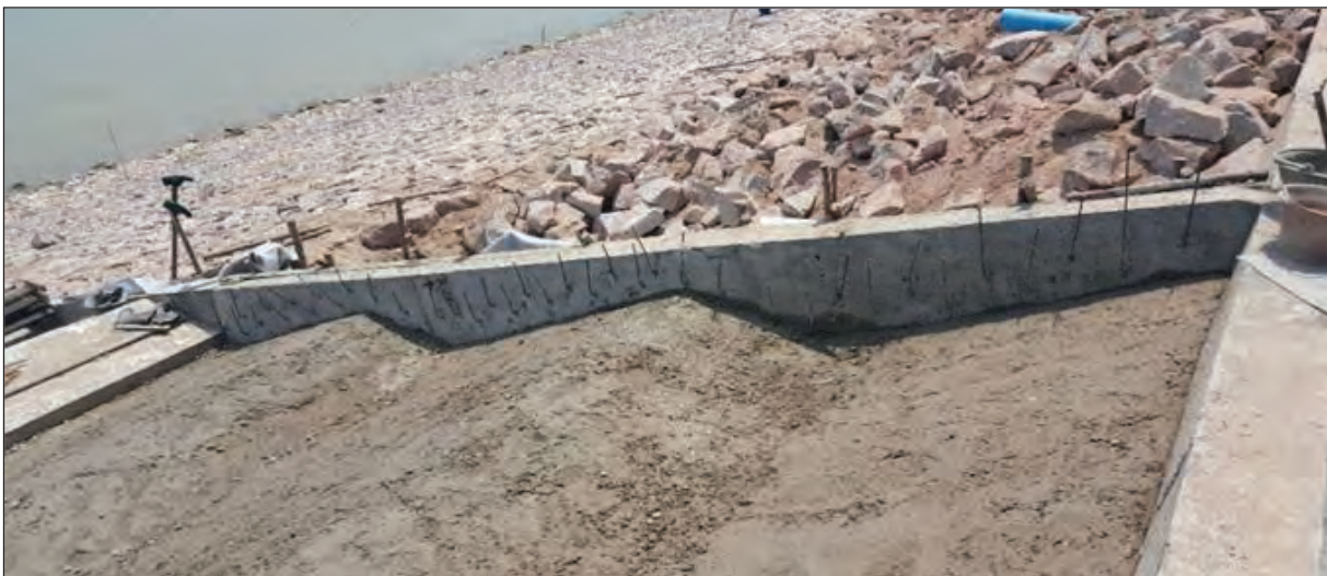
ภาพถ่ายแสดงการเทคอนกรีตหยาบรองพื้น
