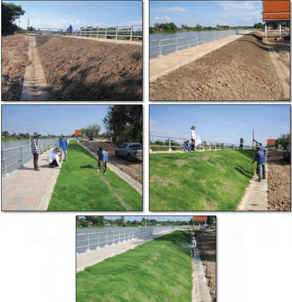
ภาพแสดงงานถมดินปลูกหญ้าหลังเขื่อน
