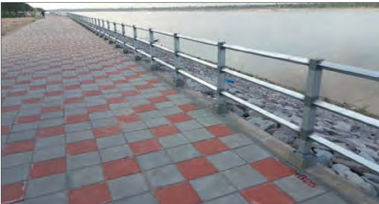
ภาพถ่ายแสดงราวกันตกเมื่อแล้วเสร็จ
