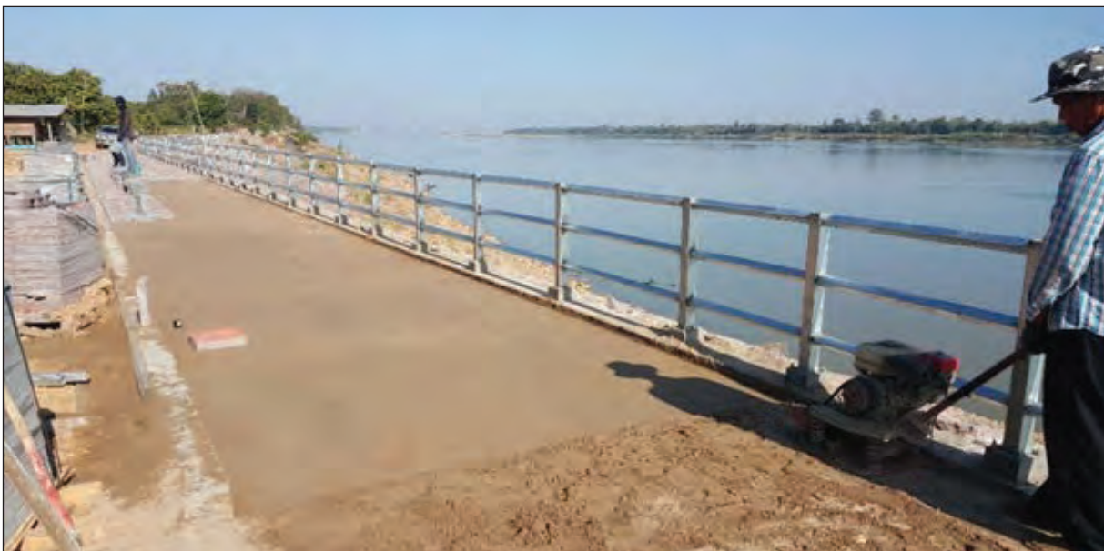
ภาพถ่ายแสดงการถมทรายปรับระดับเพื่อปูบล็อก
