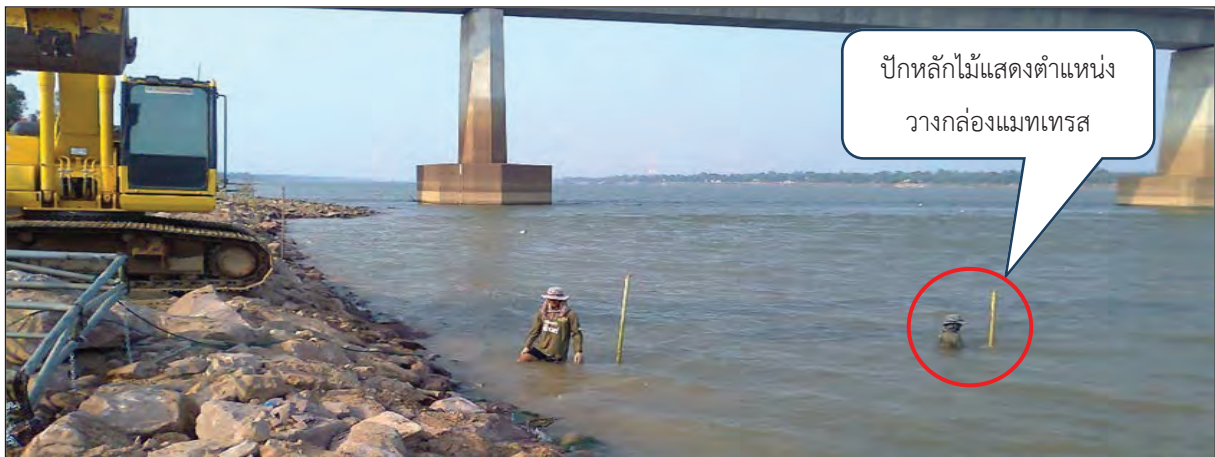
ภาพถ่ายแสดงตำแหน่งติดตั้งกล่องเมทเทรอสตื้นเขื่อน
