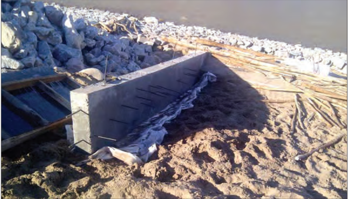
ภาพถ่ายแสดงการเทคอนกรีตคานบันได
