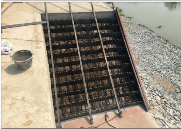
ภาพแสดงงานก่อสร้างบันไดคอนกรีตเสริมเหล็กแบบทางลงขนานเชื่อมป้องกันตลิ่ง
