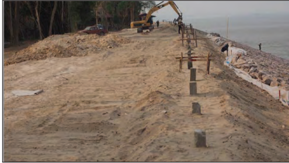
ภาพถ่ายแสดงการตอกเสาเข็มแบบสื่้เหลี่ยม
