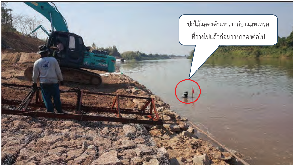
ภาพแสดงการปักหลักไม้แสดงตำแหน่งกล่องแม่ทรสที่วางไปแล้วก่อนวางกล่องต่อไป
