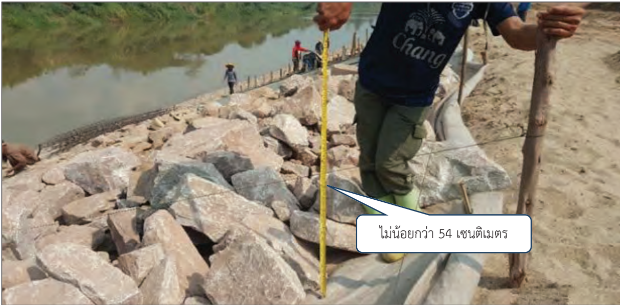
ภาพถ่ายแสดงการให้ระดับหลักเพื่อชิงเชือกระดับหินเรียงหน้าเขื่อน
