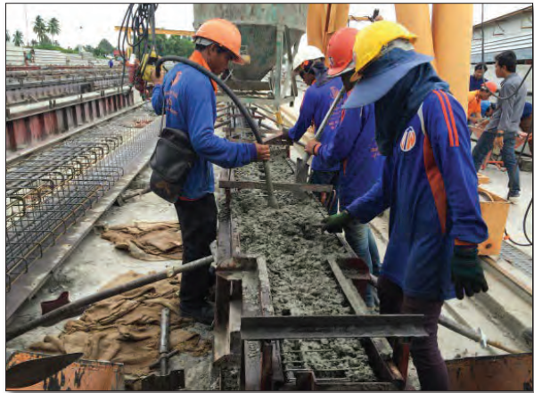
ภาพแสดงการตรวจสอบความชื้นเหลวของคอนกรีต (Slump) และการเทคอนกรีตเสาเข็ม
