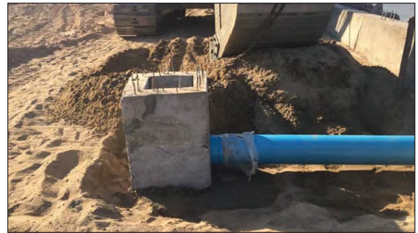
ภาพถ่ายแสดงการต่อท่อเข้ากับบ่อพัก
