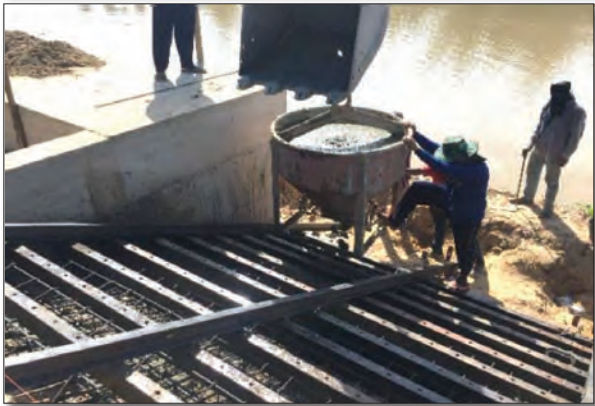
ภาพแสดงงานก่อสร้างบันไดคอนกรีตเสริมเหล็กแบบทางลงขวางเชื่อมป้องกันตลิ่ง
