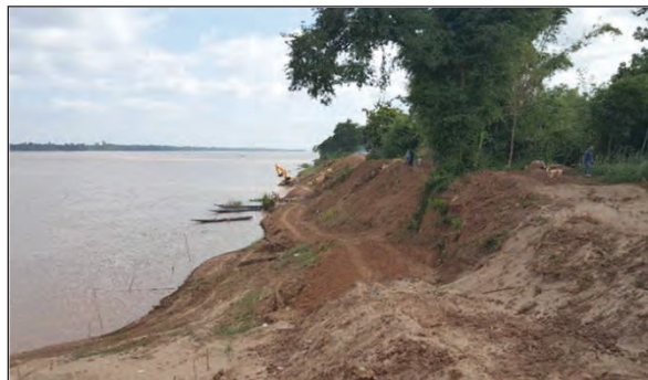
ภาพถ่ายการปรับพื้นที่ก่อสร้างบริเวณหน้าเขื่อน
