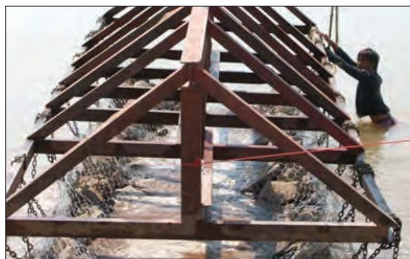
ภาพถ่ายแสดงเฟรมยกกล่องแมทเทรสแบบต่าง ๆ ที่ใช้ทำงาน
