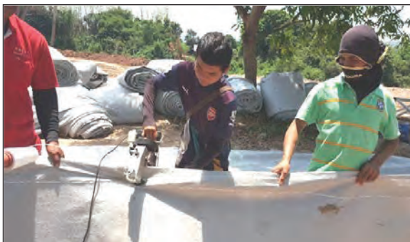
ภาพแสดงการต่อแผ่นโพลีเอทิลีนไครสทอลีนด้วยการเย็บเป็นการเย็บ ๒ แถว
