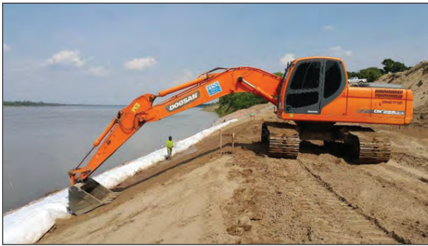
ภาพถ่ายแสดงการพับแผ่นใยสังเคราะห์เพื่อความสะดวกในการปรับระดับทรายถมในชั้นต่อไป
