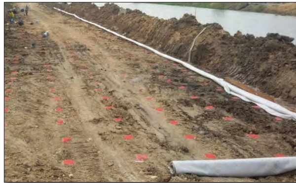
ภาพแสดงเสาเข็มเสริมความแข็งแรงของดินหลังตอกเสร็จ
