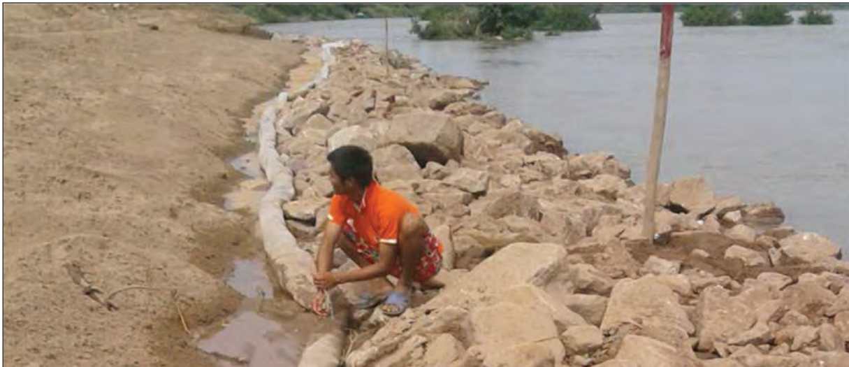
ภาพแสดงการม้วนเก็บแผ่นใยสังเคราะห์ แล้วเกลี่ยทรายปิดทับไว้ก่อนทำงานวางกล่องเมทเทรลในขั้นตอนต่อไป
