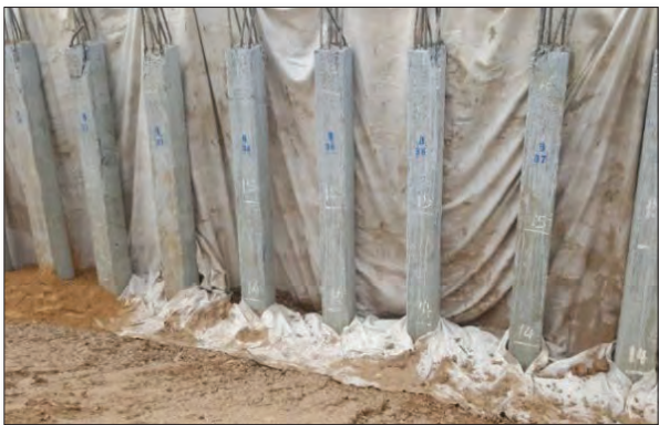
ภาพแสดงงานปูแผ่นใยสังเคราะห์และถมทรายหลังเขื่อน
