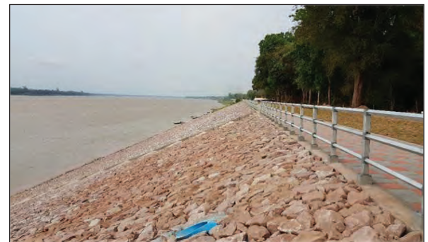
ภาพถ่ายแสดงการตัดปลายท่อระบายน้ำให้เรียบตามความลาดผิวหน้าเขื่อน
