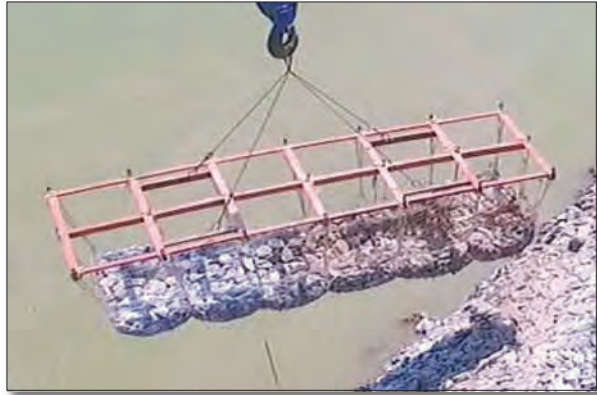
ภาพถ่ายแสดงโครงถักเหล็กสำหรับยกกล่องลวดแมทเทอร์สปรรูหินใหญ่
