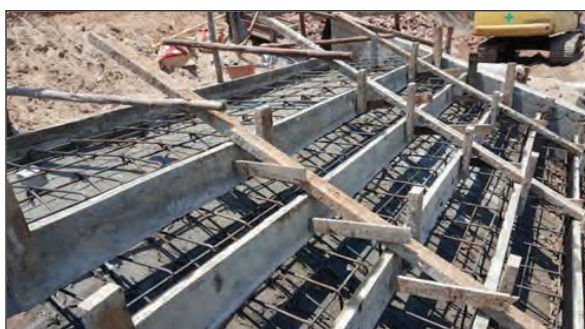
ภาพถ่ายแสดงเหล็กเสริมบันได จัดเหล็กเสริมให้อยู่ในตำแหน่ง หนุนลูกป้อนยึดแบบ
