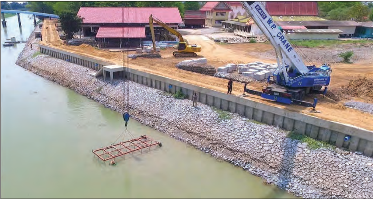
ภาพแสดงการวางกล่องลวดตาข่ายแมทเทอร์สปรรูหินใหญ่ โดยใช้รถเครนยกไปติดตั้ง
