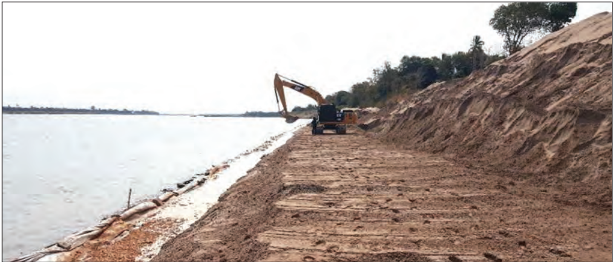
ภาพถ่ายแสดงการถมทรายขึ้นมาถึงขั้นที่จะทำการปรับ Slope
