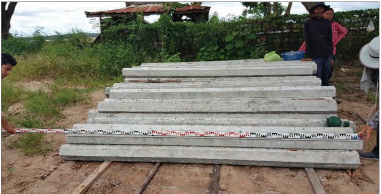
ภาพถ่ายแสดงเสาเข็ม หกเหลี่ยมกลวง ขนาด \varnothing ๐.๑๕ เซนติเมตร ยาว ๒.๕๐ เมตร
