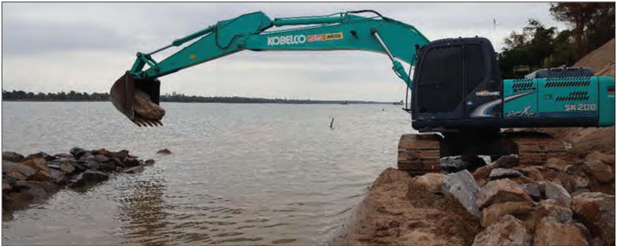
ภาพถ่ายแสดงการทิ้งหินดินเขื่อน คันหินดินเขื่อนด้านใน
