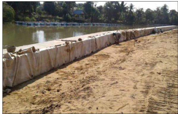
ภาพแสดงงานปูแผ่นใยสังเคราะห์และถมทรายหลังเขื่อน
