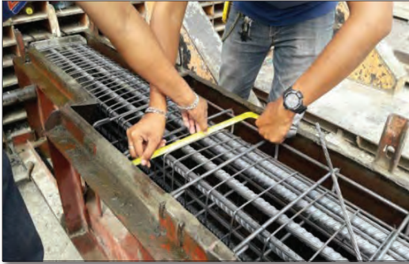
ภาพแสดงการตรวจสอบขนาดเสาเข็ม ขนาดและระยะลวดเหล็กปลอก
