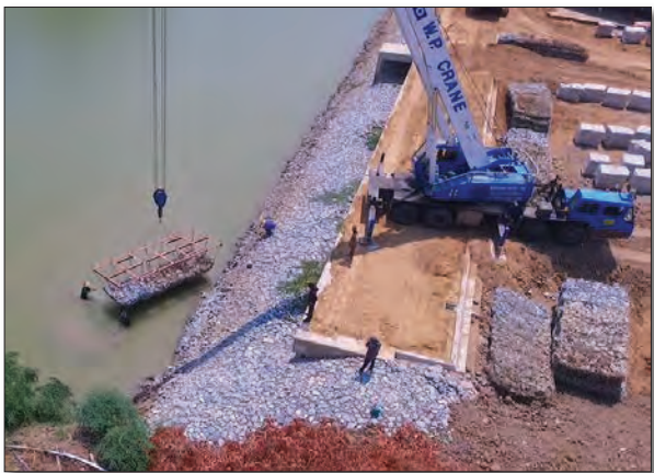
ภาพถ่ายแสดงโครงถักเหล็กสำหรับยกกล่องลวดแมทเทอร์สปรรูหินใหญ่
