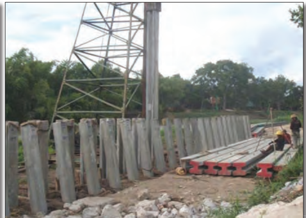
ภาพแสดงการตอกเสาเข็มคอนกรีตอัดแรง B (ตอกเอียง)
