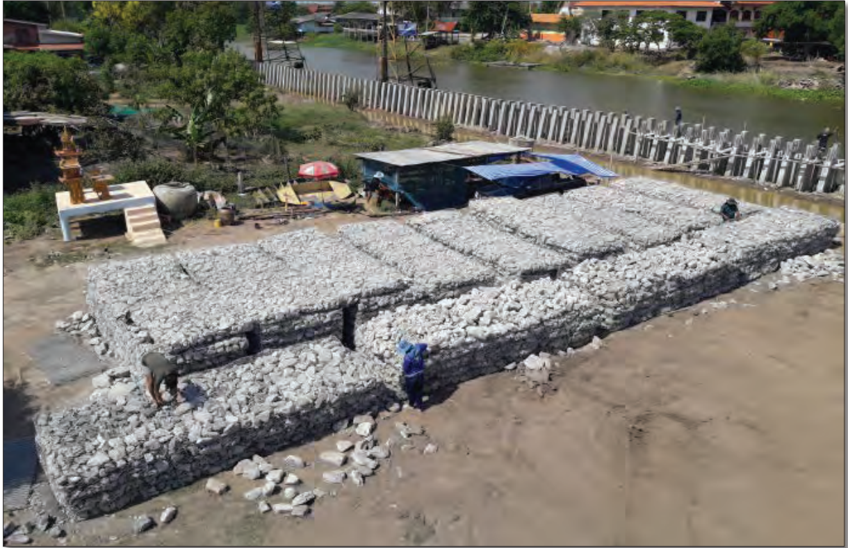
ภาพแสดงกล่องเมทเทรลที่บรรจุหินใหญ่วางกองเป็นชั้น ๆ เนื่องจากมีข้อจำกัดพื้นที่ทำงาน
