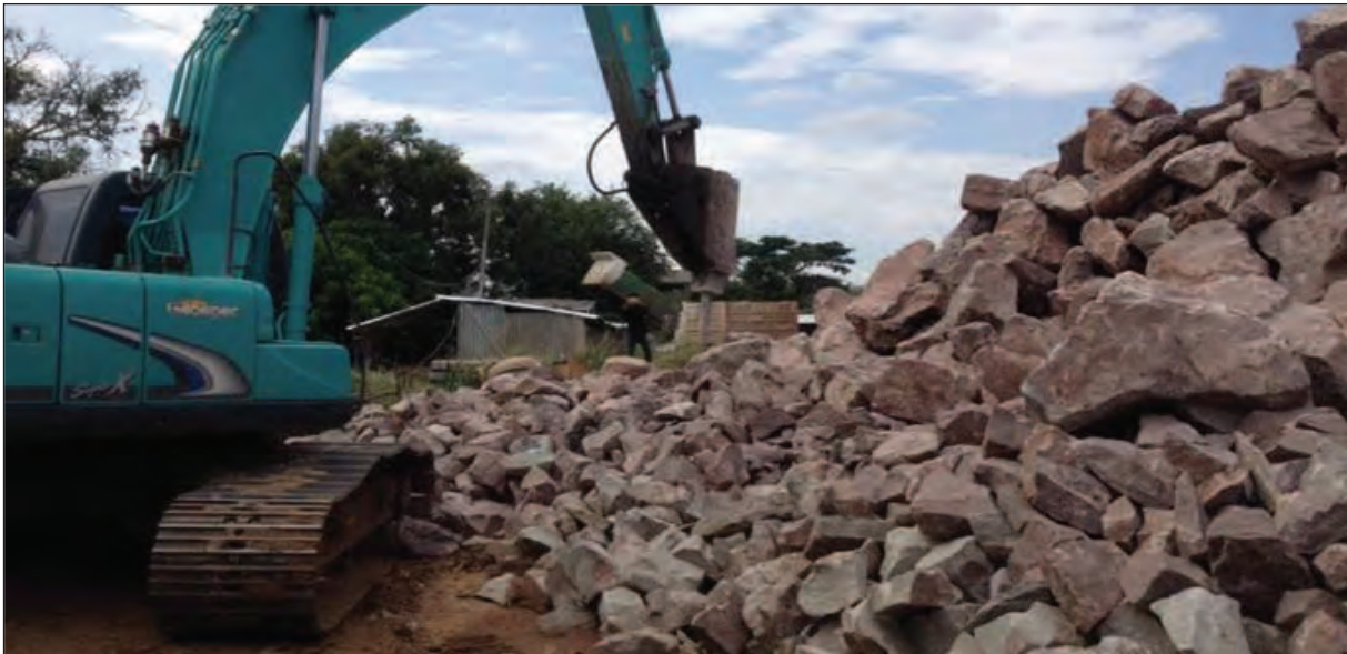
ภาพถ่ายแสดงการย่อยหินใหญ่ให้ได้ขนาดไม่ใหญ่กว่า ๐.๕๐ เมตร ก่อนนำไปเป็นหินเรียงหน้าเขื่อน
