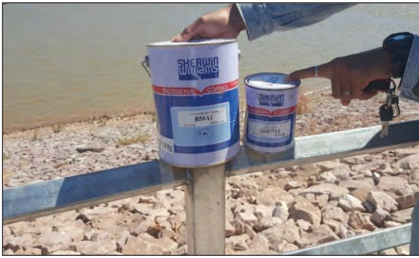
ภาพถ่ายแสดงงานทาสีตงแต่งรอยเชื่อม ด้วยสี ZINC RICH PRIMER (COLD GALVANIZED)
