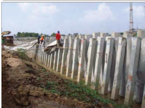
ภาพแสดงการติดตั้งแผ่นใยสังเคราะห์หลังแผงกรู คสล.
