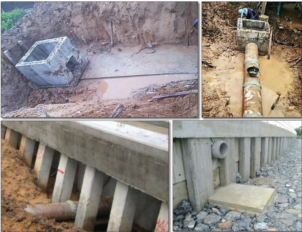
ภาพแสดงการก่อสร้างท่อระบายน้ำ คสล.
