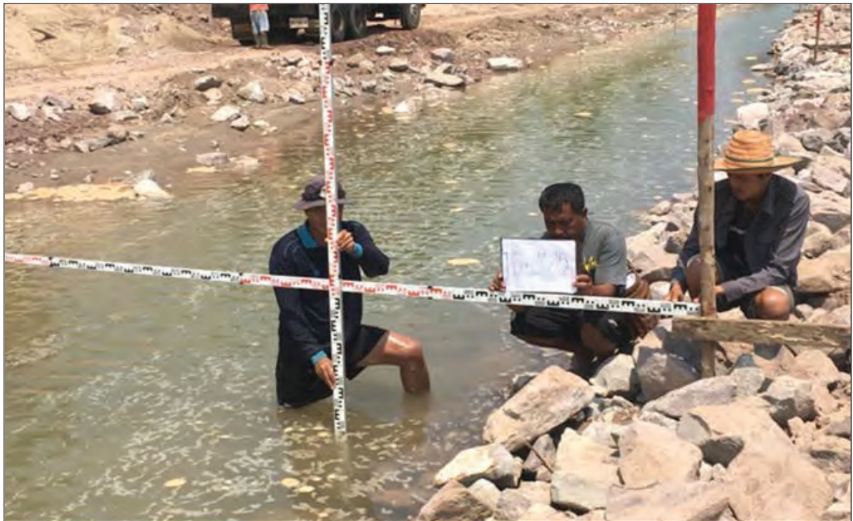
ภาพถ่ายแสดงการตรวจสอบ Slope ของคันหินด้านใน
