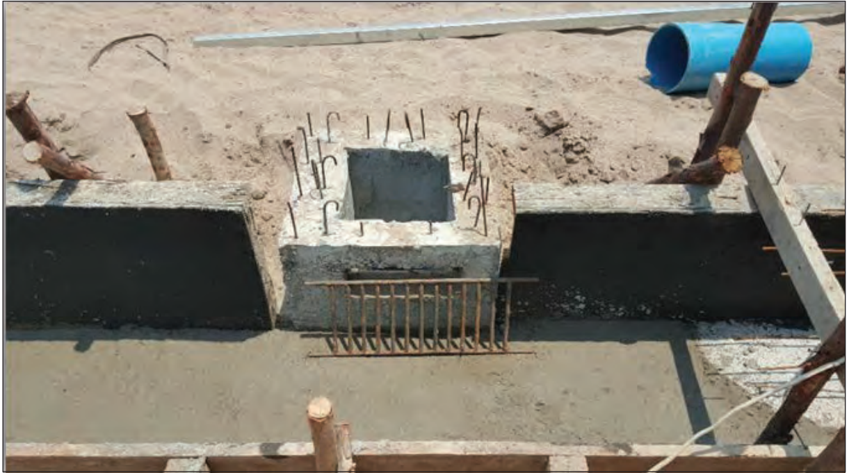
ภาพถ่ายแสดงงานติดตั้งตะแกรงดักขยะ
