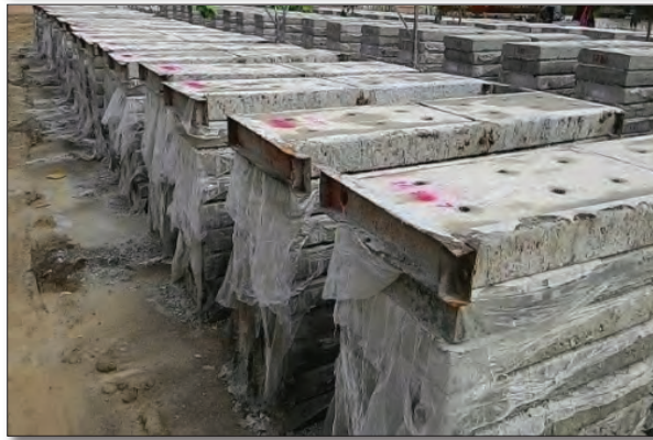
ภาพแสดงการผูกเหล็ก เทคอนกรีต กองแผงกรู คสล.
