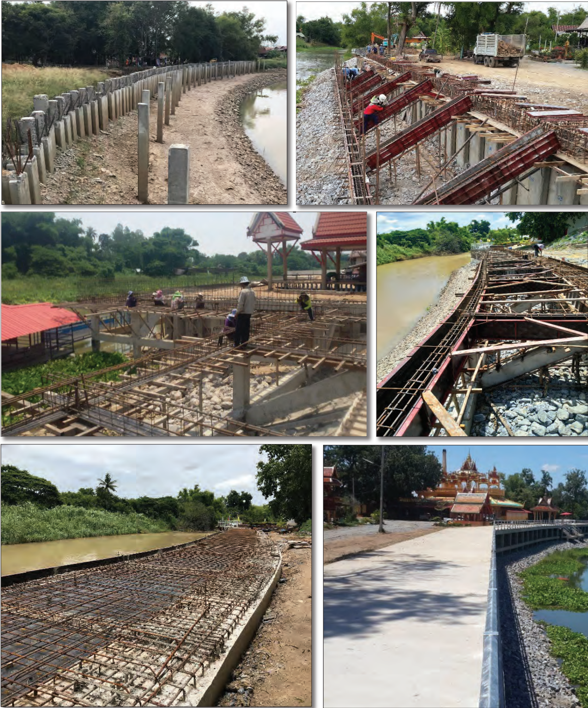
ภาพแสดงงานก่อสร้างเขื่อนป้องกันตลิ่งแบบเขื่อนโต๊ะ
