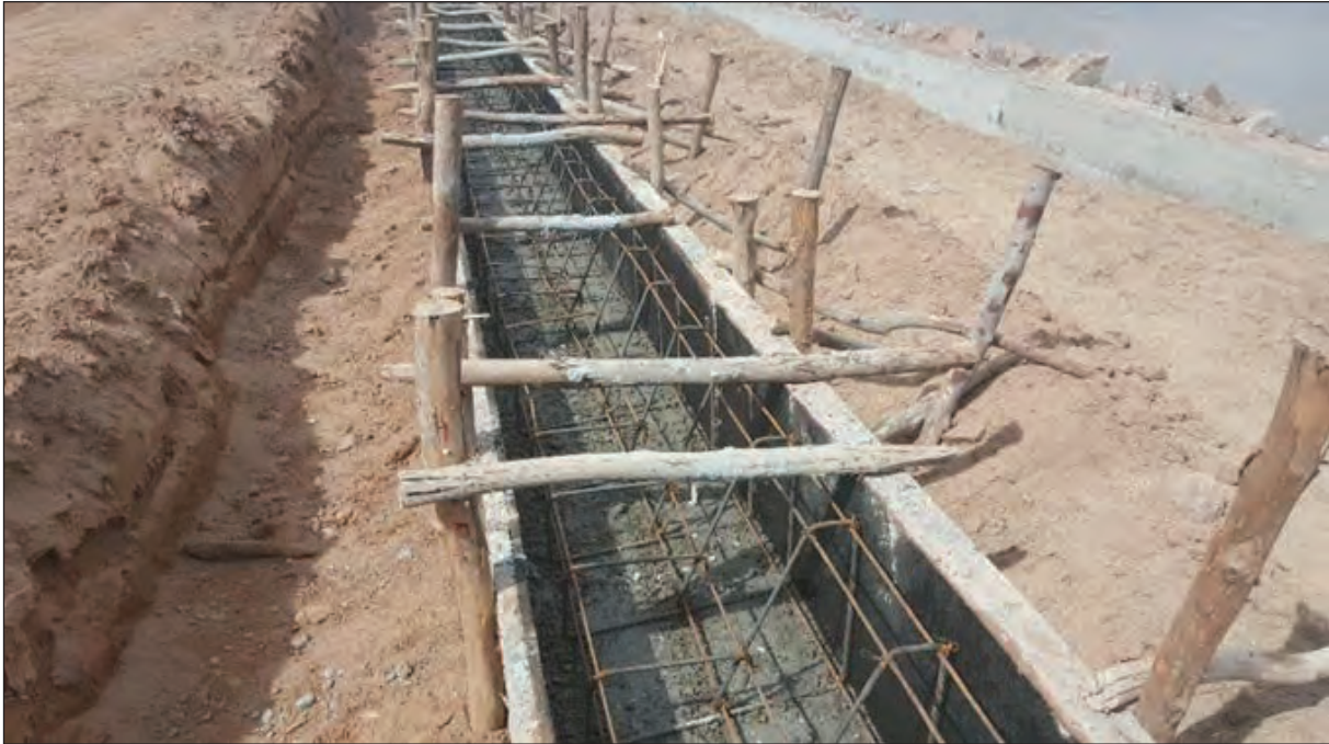
ภาพถ่ายแสดงวางเหล็กเสริมเทคอนกรีตส่วนล่างปรับระดับเอียงลาดเข้าสู่บ่อพัก
