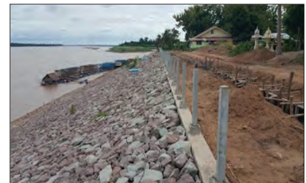
ภาพถ่ายแสดงเสาราวกันตกที่ทำการติดตั้งเสาและแผ่นเหล็กรองรับและทำการชุบสังกะสีมาแล้ว
