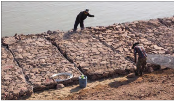
ภาพแสดงกล่องแมทเทรสที่บรรจุหินใหญ่พร้อมแทรกโครงด้วยหินเล็ก
