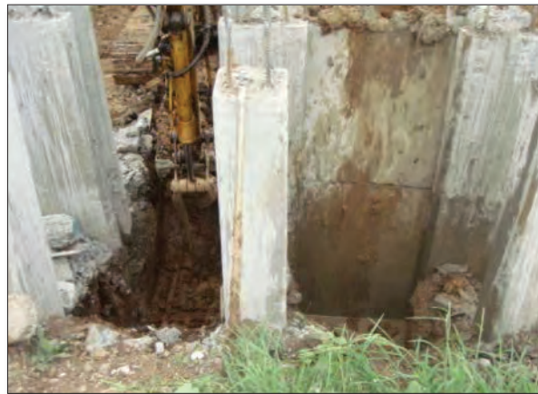
ภาพแสดงการผูกเหล็ก เทคอนกรีต กองแผงกรู คสล.
