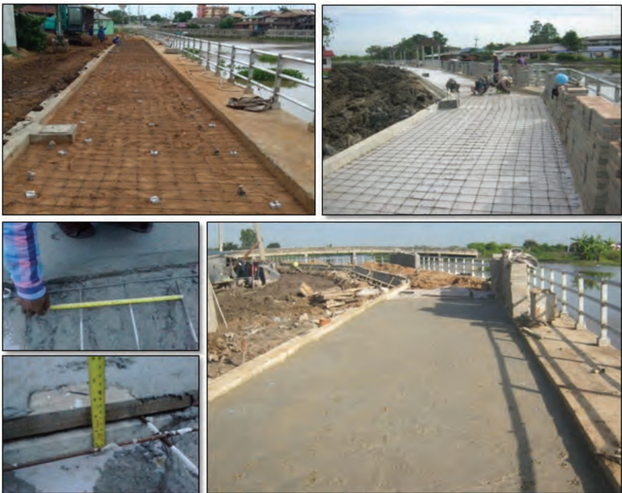
ภาพแสดงการขั้นตอนการเทคอนกรีตหยาบรองแผ่นพื้นคอนกรีตทางเท้า
