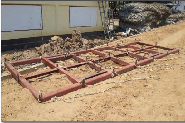
ภาพถ่ายแสดงโครงถักเหล็กสำหรับยกกล่องลวดแมทเทอร์สปรรูหินใหญ่
