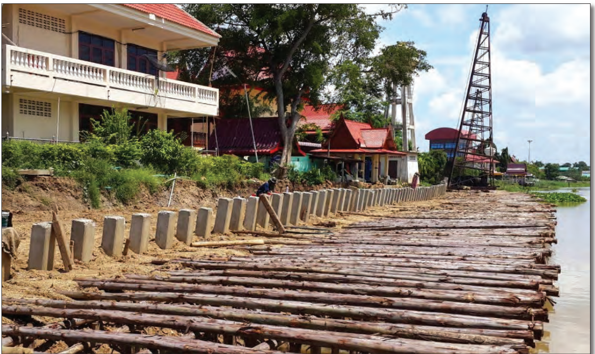
ภาพแสดงการก่อสร้างนั่งร้านชั่วคราวสำหรับตอกเสาเข็ม
