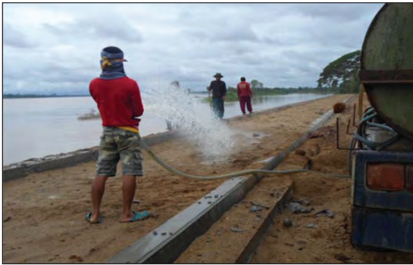
ภาพถ่ายแสดงการถมทรายปรับระดับสำหรับงานก่อสร้างทางเท้า
