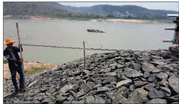
ภาพแสดงการตรวจสอบ Slope ของหินทิ้งปิดหัว - ท้ายเขื่อน ๑ : ๒
