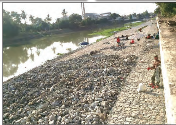
ภาพแสดงการติดตั้งกล่องลวดตาข่ายแมทเทรสบริเวณหน้าเขื่อน
