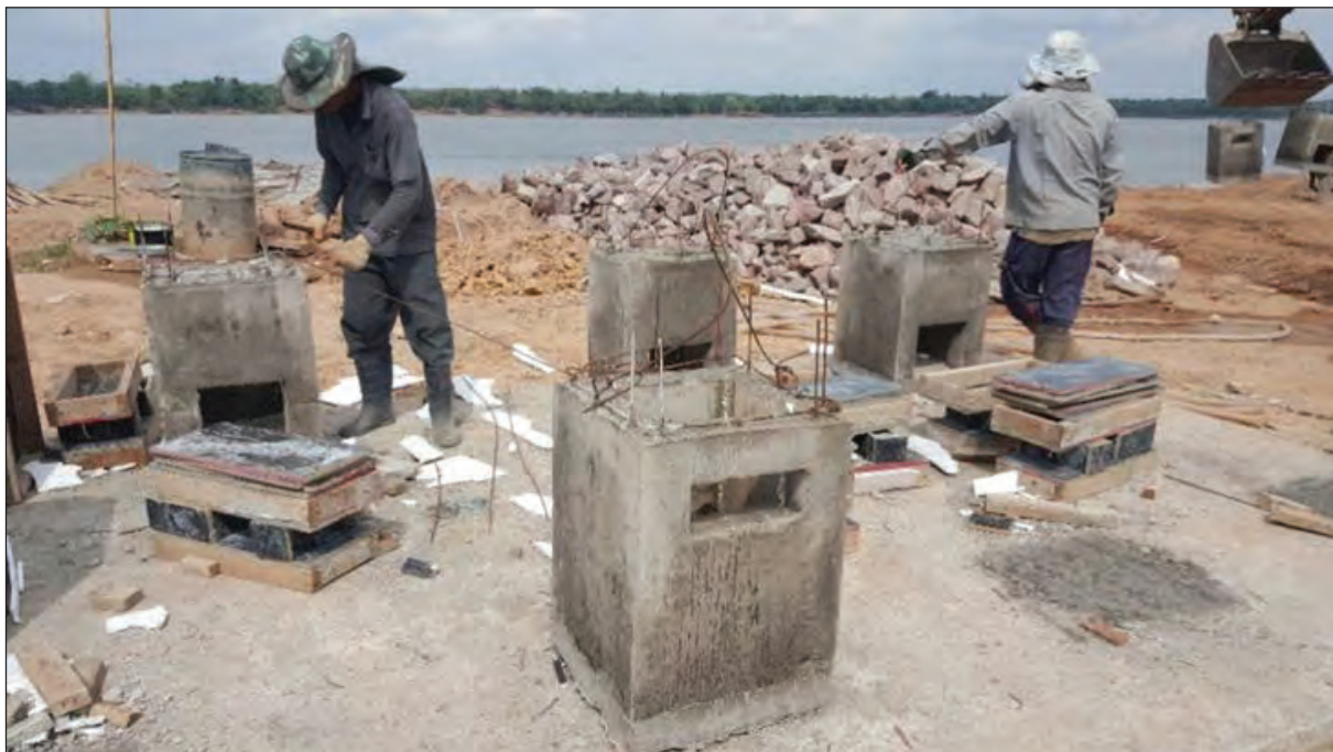
ภาพแสดงงานหล่อบ่อพักคอนกรีตเสริมเหล็ก
