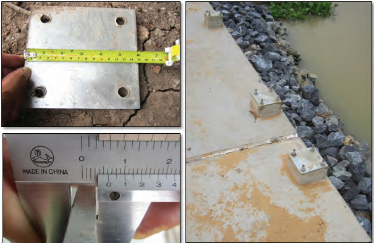
ภาพแสดงงานติดตั้งแผ่นเหล็กฐานเสาราวกันตก
