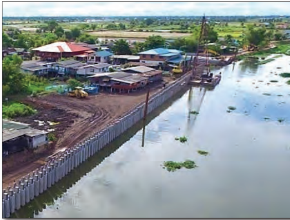
ภาพแสดงการตอกเสาเข็มคอนกรีตอัดแรง A (ตอกตรง) ด้วยปั้นจั่นโป๊ะ
