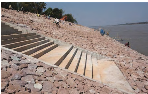
ภาพแสดงงานก่อสร้างบันไดเมื่อแล้วเสร็จ
