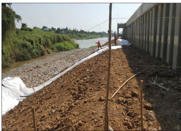
ปรับดินให้ได้ระดับและปูแผ่นใยสังเคราะห์ดินเขื่อน
