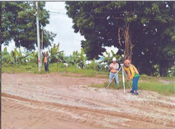
BM-3 บนหัวไม้โคนเสาไฟฟ้า Elev=100.211
