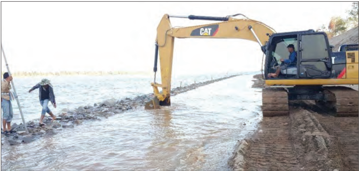
ภาพถ่ายแสดงการตบแต่งคันหินด้านใน
