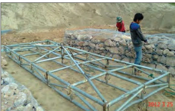
ภาพถ่ายแสดงเฟรมยกกล่องแมทเทรสแบบต่าง ๆ ที่ใช้ทำงาน
