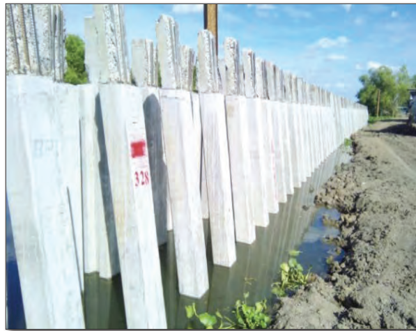
ตอกเสาเข็มคอนกรีตอัดแรง B (ตอกเอียง) ด้วยปั้นจั่นโป๊ะ
