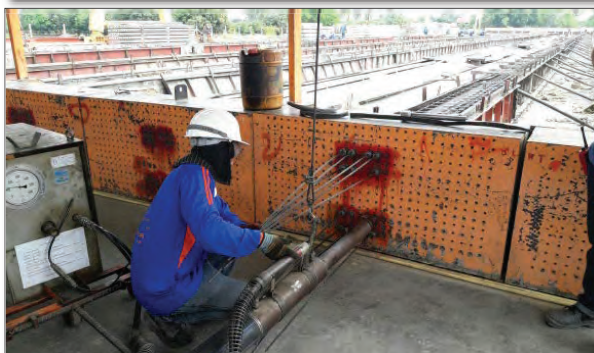
ภาพแสดงการดึงลวดอัดแรงและตรวจสอบระยะยึดของลวดอัดแรง
