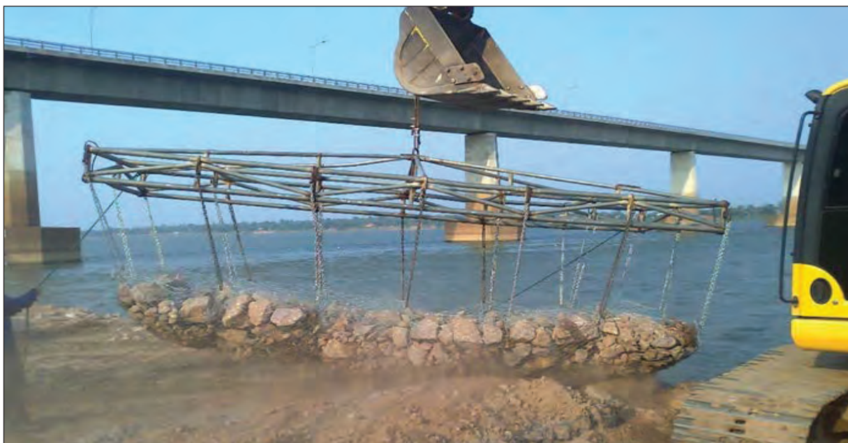
ภาพถ่ายแสดงตำแหน่งติดตั้งกล่องเมทเทรอสตื้นเขื่อน
