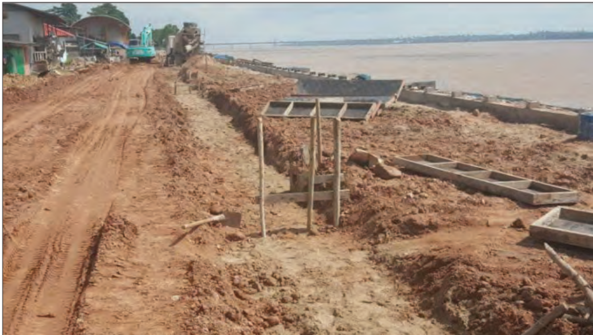
ภาพถ่ายแสดงงานกำหนดแนวและตีผัง
