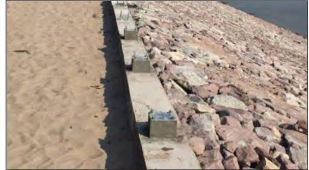
ภาพถ่ายแสดงน็อตที่ฝังไว้ในคานและหล่อคอนกรีตแทนรองรับเสาเหล็ก
