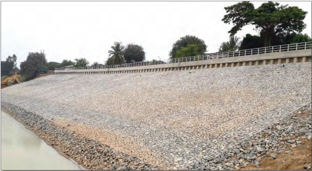
การเรียงหินใหญ่พร้อมแทรกโพรงด้วยหินเล็กหน้าเขื่อน
