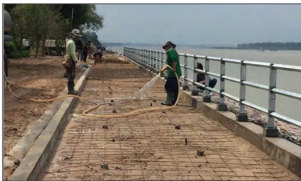
ภาพถ่ายแสดงการเทคอนกรีตหยาบแล้วเสร็จแสดงการฝังท่อ PVC. ขนาด 1"
