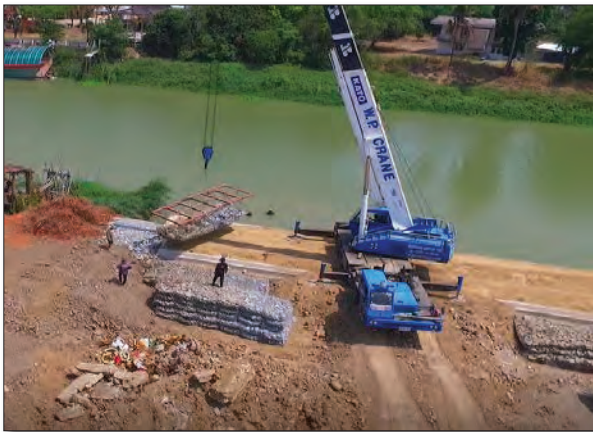
ภาพถ่ายแสดงโครงถักเหล็กสำหรับยกกล่องลวดแมทเทอร์สปรรูหินใหญ่
