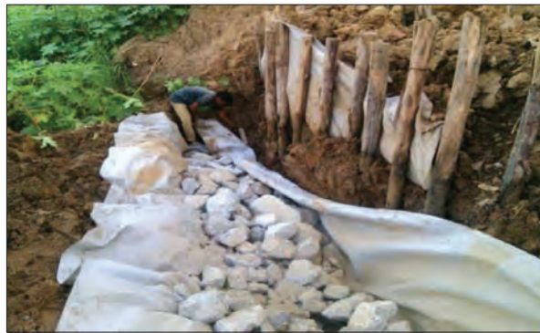
แก้ไขน้ำใต้ดินโดยการทำรางกรวด
