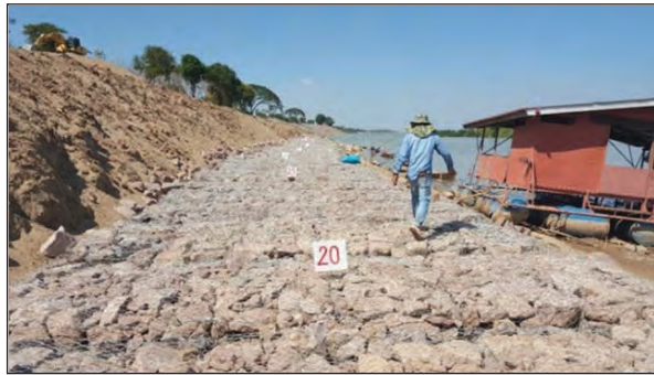
ภาพแสดงกล่องแมทเทรสที่บรรจุหินใหญ่พร้อมแทรกโครงด้วยหินเล็ก
