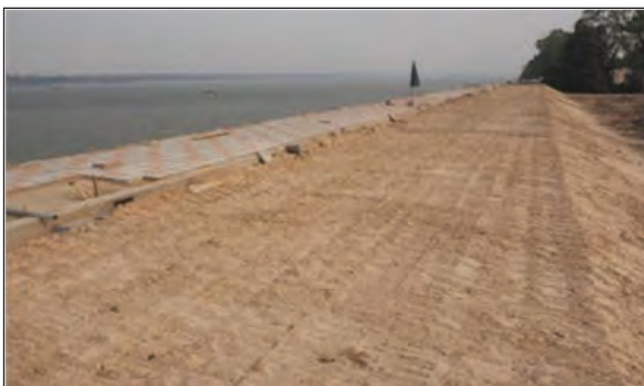
ภาพถ่ายแสดงงานถมดินหลังเขื่อน
