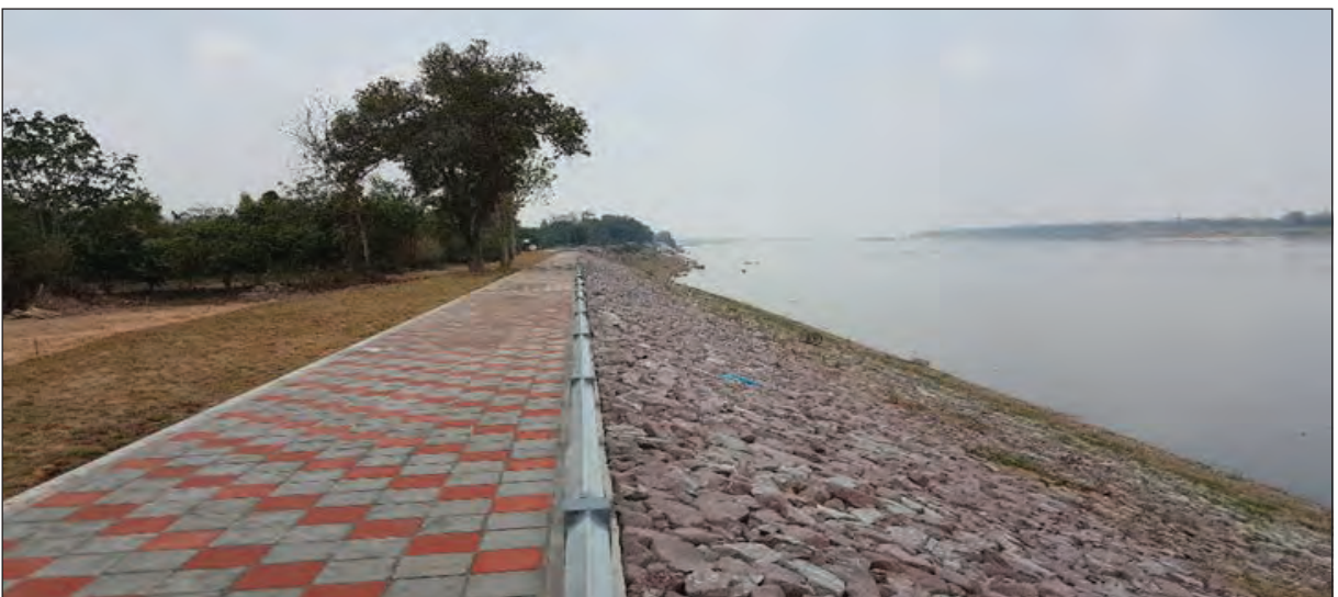
ภาพถ่ายแสดงงานก่อสร้างเมื่อแล้วเสร็จ
