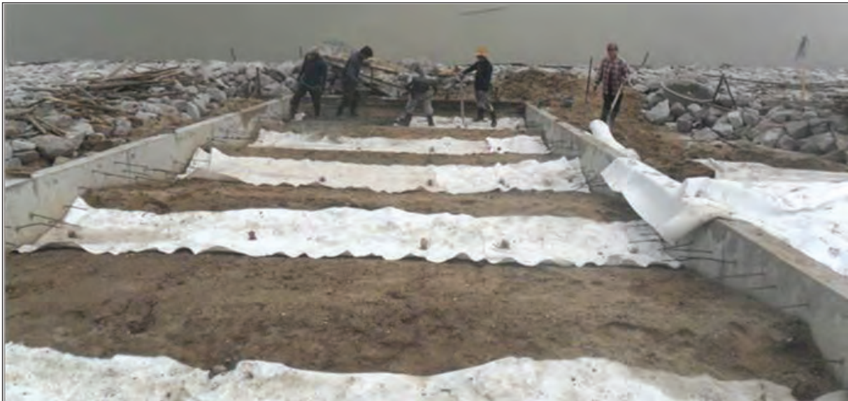
ภาพถ่ายแสดงการปูวัสดุกรองที่รอยต่อระหว่างช่วงตามแบบก่อนเทคอนกรีตหยาบรองพื้น
