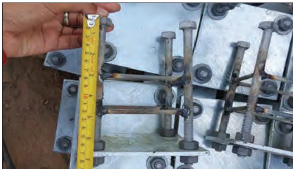
ภาพถ่ายแสดงน็อตที่ฝังไว้ในคานและหล่อคอนกรีตแทนรองรับเสาเหล็ก
