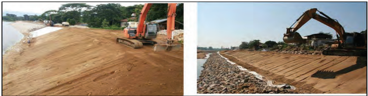
ภาพแสดงรูปแบบและงานถมทรายบดอัดแน่นหน้าเขื่อน
