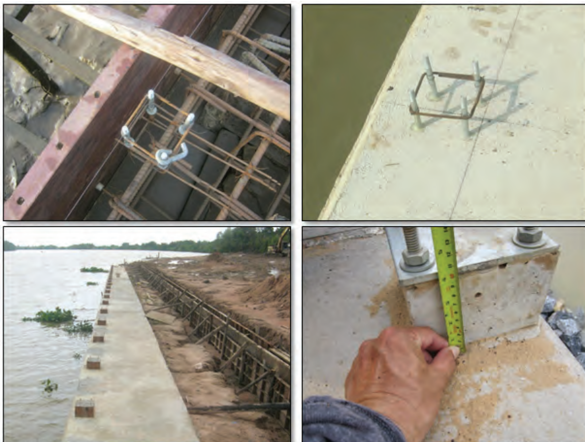
ภาพแสดงงานติดตั้งน็อตสกรูชุบสังกะสีพร้อมเหล็กปลอกและเทคอนกรีต ฐานเสาราวกันตก
