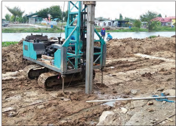
ภาพแสดงการตอกเสาเข็มด้วยรถปั้นจั่น
