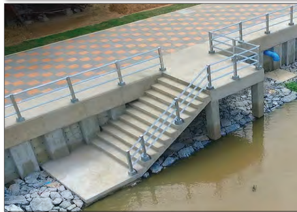
ภาพแสดงงานก่อสร้างบันไดคอนกรีตเสริมเหล็กแบบทางลงขนานเชื่อมป้องกันตลิ่ง
