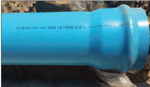
ภาพถ่ายแสดงท่อ PVC ชั้น 8.5 ขนาด \varnothing 200 มม. ชนิดต่อกับแหวนยาง
