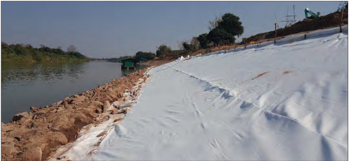
ภาพแสดงแผ่นโพลีเอทิลีนไครสทอลีนต่อเข้ากับแผ่นต่อไป
