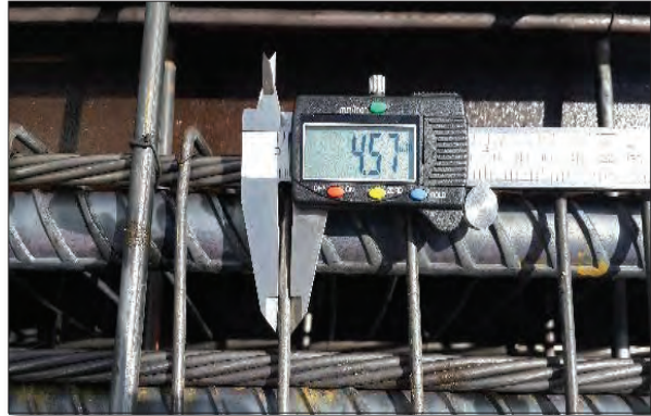
ภาพแสดงการตรวจสอบขนาดเสาเข็ม ขนาดและระยะลวดเหล็กปลอก
