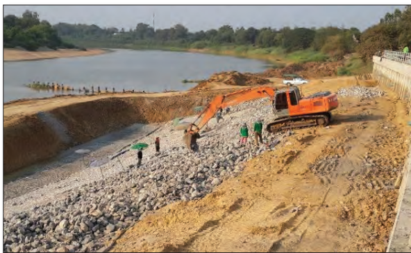
ภาพแสดงการเรียงหินใหญ่พร้อมแทรกโพรงด้วยหินเล็กหน้าเขื่อน
