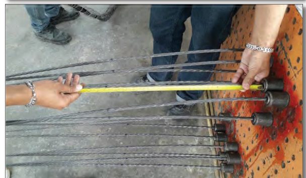
ภาพแสดงการดึงลวดอัดแรงและตรวจสอบระยะยึดของลวดอัดแรง
