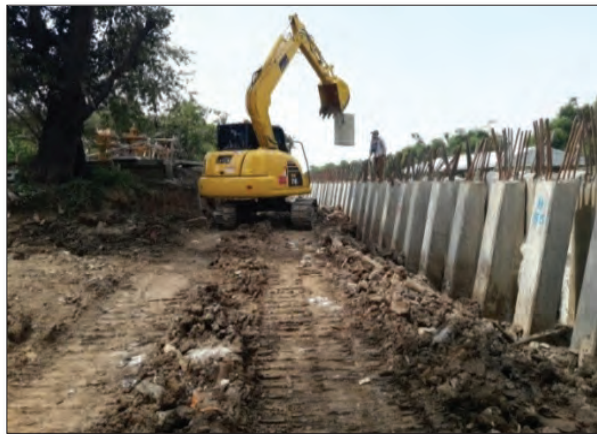
ภาพแสดงการผูกเหล็ก เทคอนกรีต กองแผงกรู คสล.
