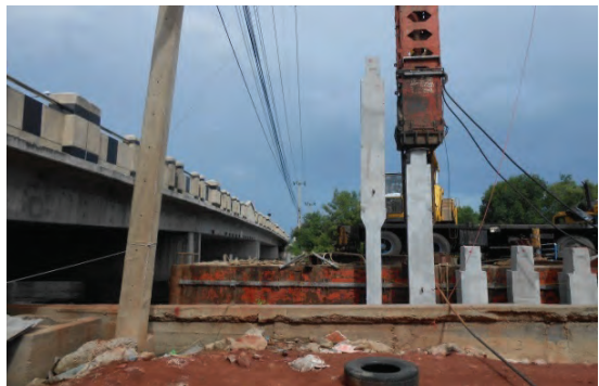
ภาพแสดงการส่งงานตอกเสาเข็มคอนกรีตอัดแรง
