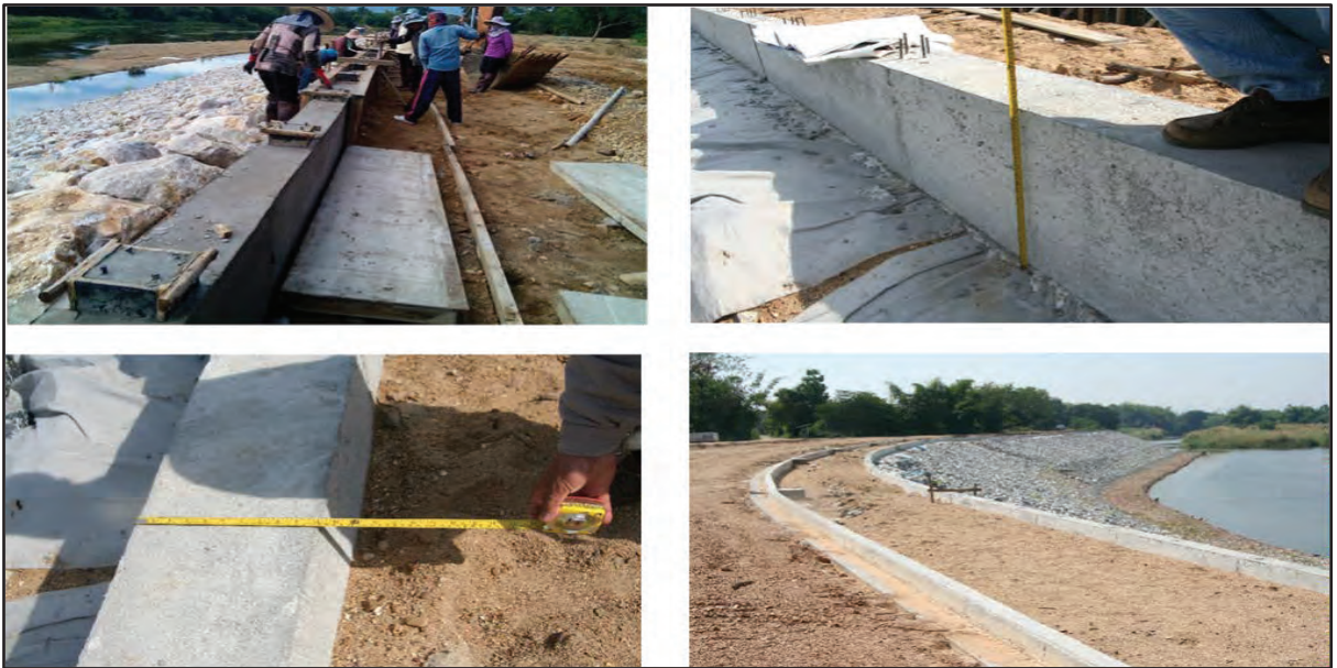
ภาพแสดงงานโครงสร้างคาน คสล. รับราวกันตก และคันทัน คสล.
