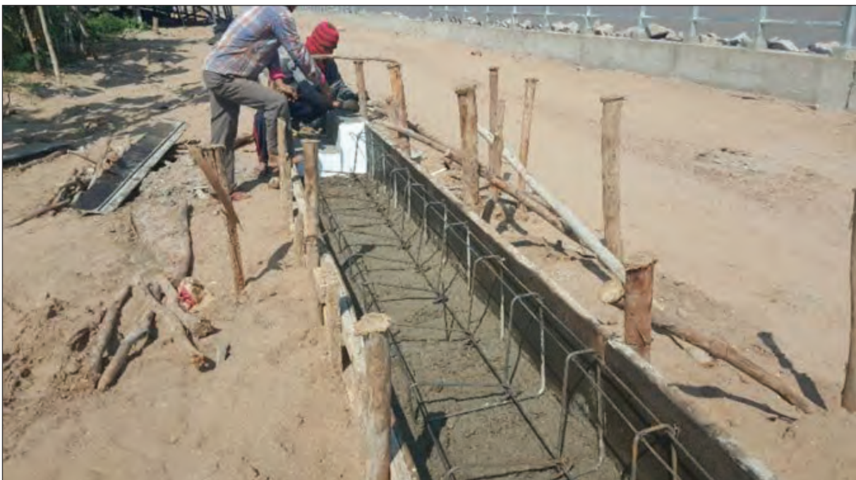
ภาพถ่ายแสดงงานตอกหลักให้ระดับปรับลาดเอียงตามแบบ
