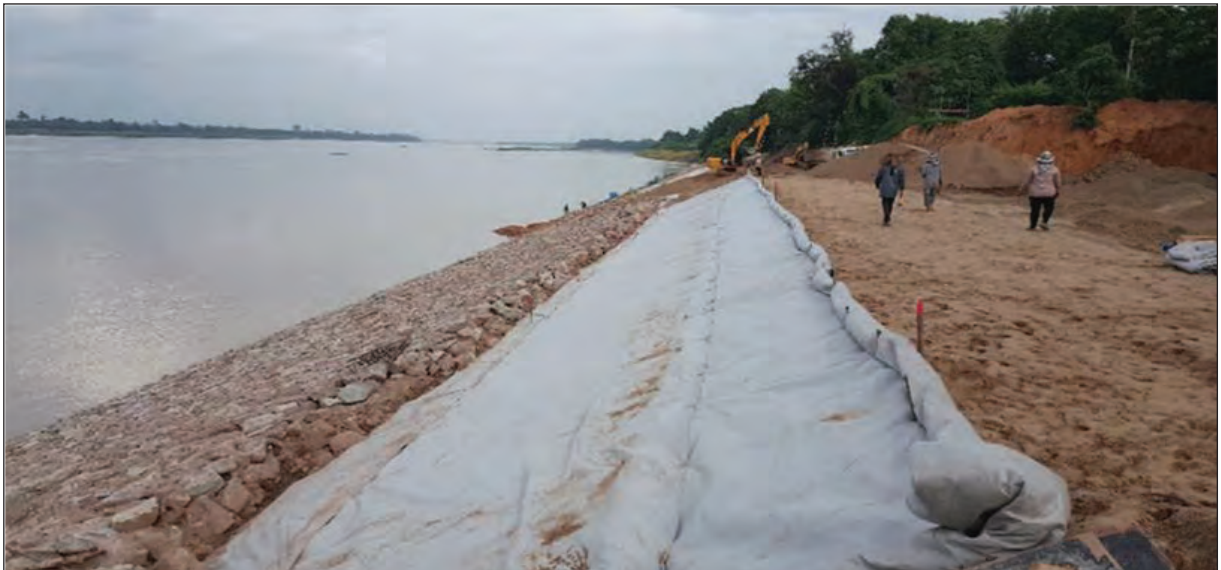
ภาพแสดงการปูวัสดุกรอง (แผ่นโพลีเอทิลีนไครสทอลีน)
