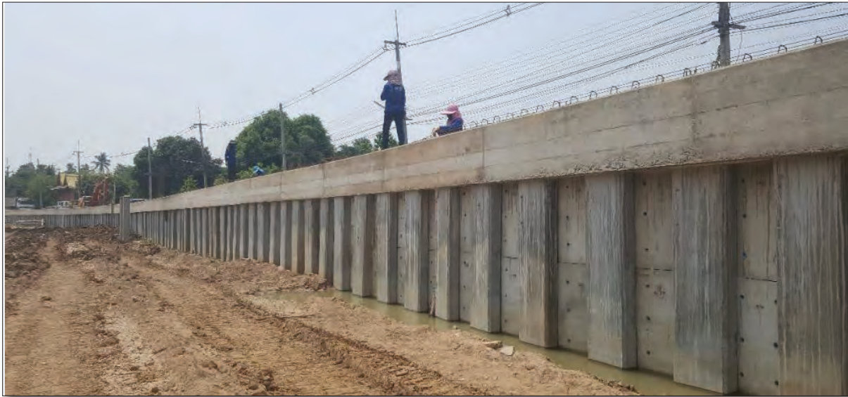
ภาพแสดงงานหล่อคานรัดหัวเสาเข็มแล้วเสร็จ
