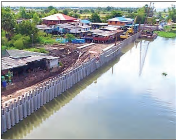
ตอกเสาเข็มคอนกรีตอัดแรง B (ตอกเอียง) ด้วยปั้นจั่นโป๊ะ
