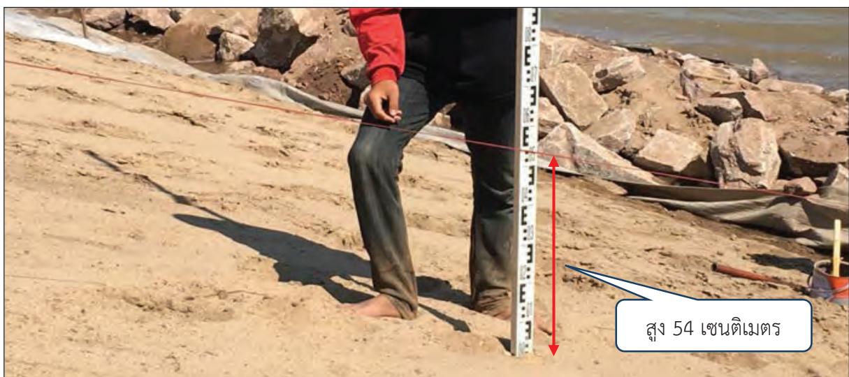
ภาพถ่ายแสดงการตรวจสอบความหนาของชั้นหินเรียง เมื่อปรับระดับทรายนูนแล้วเสร็จก่อนการปูวัสดุกรองปิดทับทรายนูน
