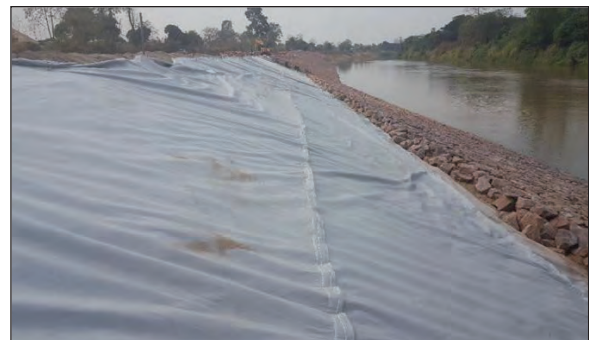
ภาพแสดงการต่อแผ่นโพลีเอทิลีนไครสทอลีนด้วยการเย็บเป็นการเย็บ ๒ แถว
