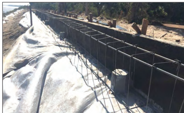
ภาพถ่ายแสดงการเสริมเหล็กคานรับราวกันตก จะเห็นเสาเข็มฝังอยู่ในคาน ๒๐ เซนติเมตร
