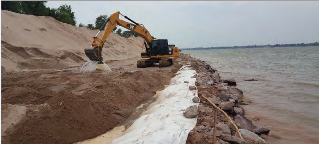
ภาพถ่ายแสดงการปูวัสดุกรอง (แผ่นโพลีเอทิลีน) ความกว้าง ๖ เมตร แล้วถมทรายทับ จะมีขอบแผ่นโพลีเอทิลีนเหลือประมาณ ๑ เมตร ให้ม้วนเก็บไว้ต่อทาบในขั้นตอนต่อไป
