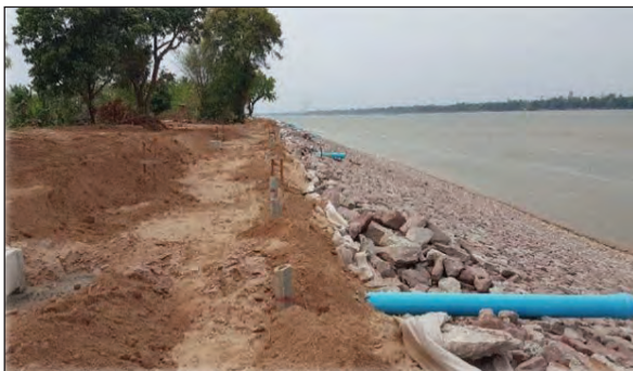
ภาพถ่ายแสดงการต่อท่อระบายน้ำออกไปหน้าเขื่อน
